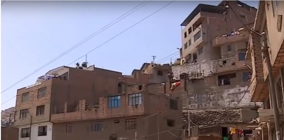
Figura 2: Vulnerabilidad sísmica debido a la informalidad en la construcción. Fuente: Cuarto Poder
