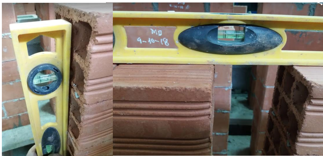
Figura 38: Nivelación de hiladas. Fuente: Material propio.
