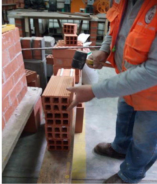
Figura 37: Golpeo del ladrillo para asegurar óptima unión. Fuente: Material propio.
