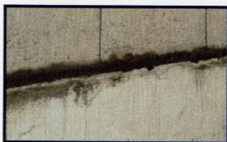
Nivelamiento primera hilada
