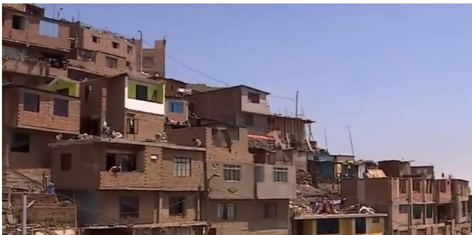
Figura 3: Informalidad en la construcción en Asentamientos Humanos. Fuente: Cuarto Poder.
