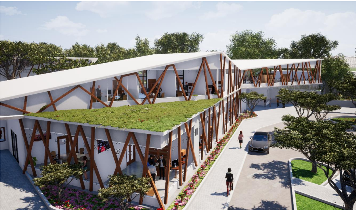
1. Vista zona administrativa.
