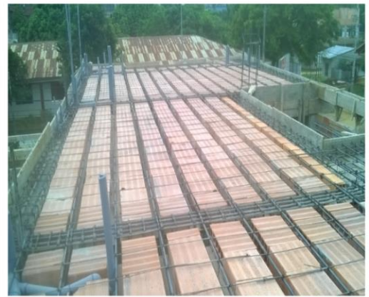
Panel fotográfico en la partida de Losa Aligerada: ladrillos huecos de 15x30x30 cm
