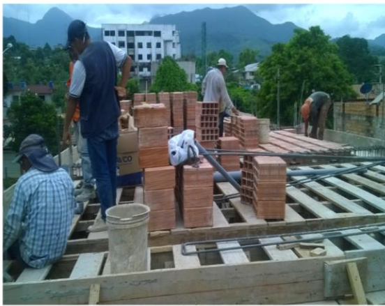
Panel fotográfico en la partida de Losa Aligerada: ladrillos huecos de 15x30x30 cm
