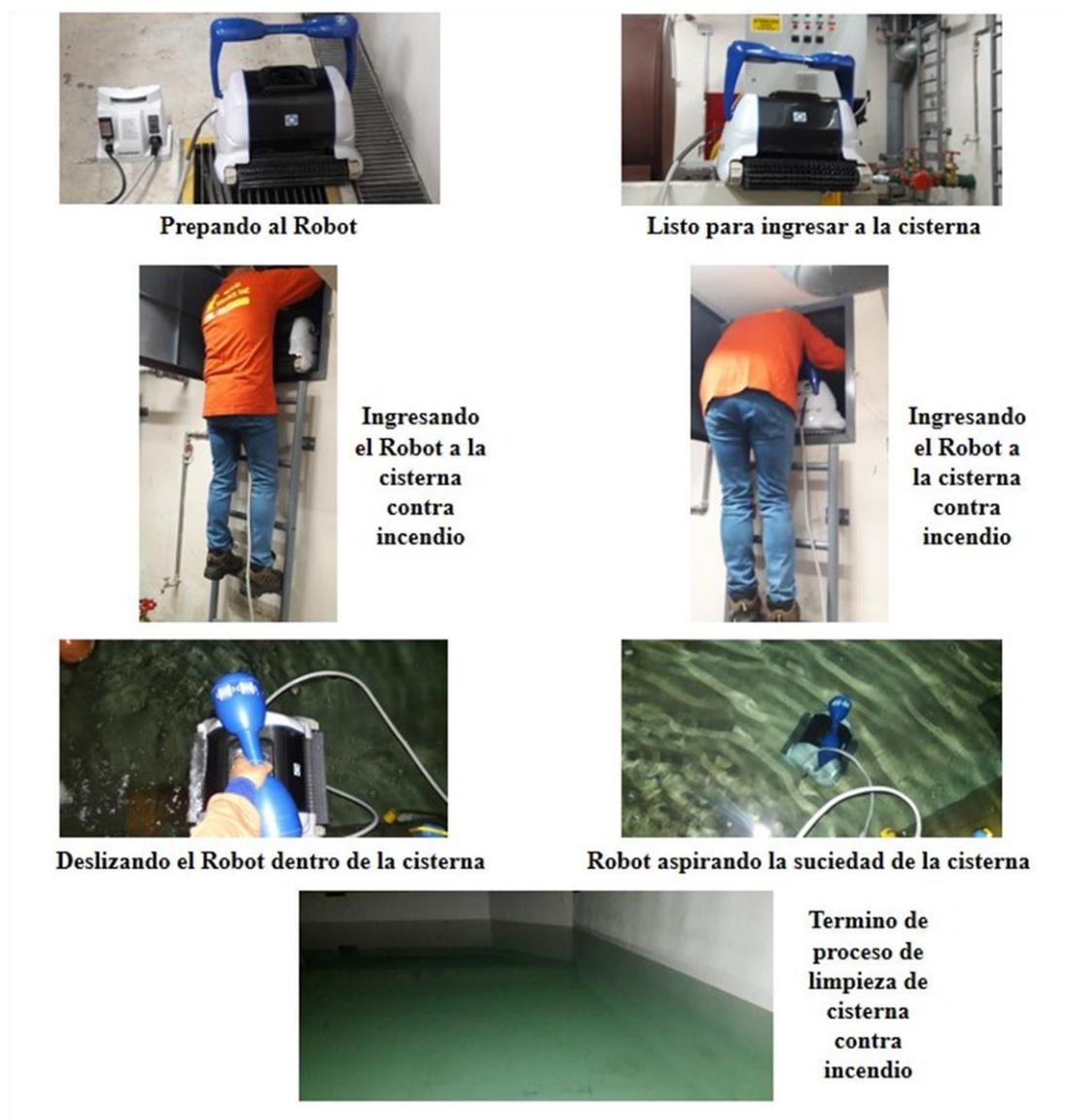
**Figura 42.** Proceso de limpieza de cisterna con el Robot. – Cisterna Ejecutada (POS – PRUEBA)
