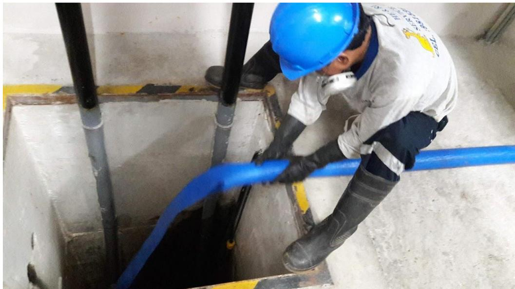
**Figura 24.** Retiro del agua de la cisterna contra incendio al pozo séptico
