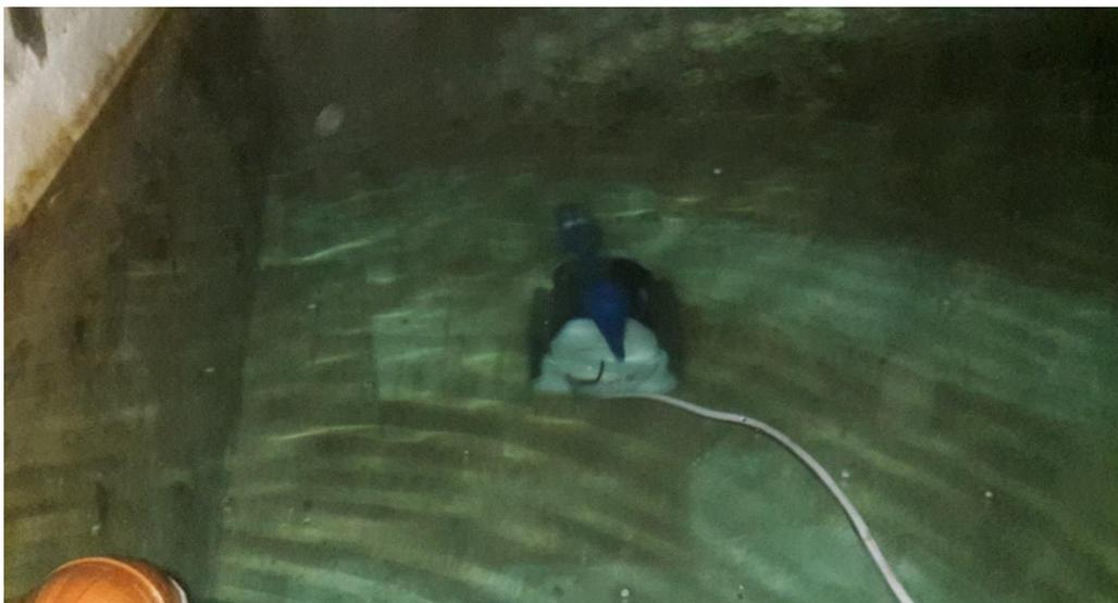
**Figura 36.** Limpieza de cisterna contra incendio utilizando el Robot (PRE – PRUEBA)
