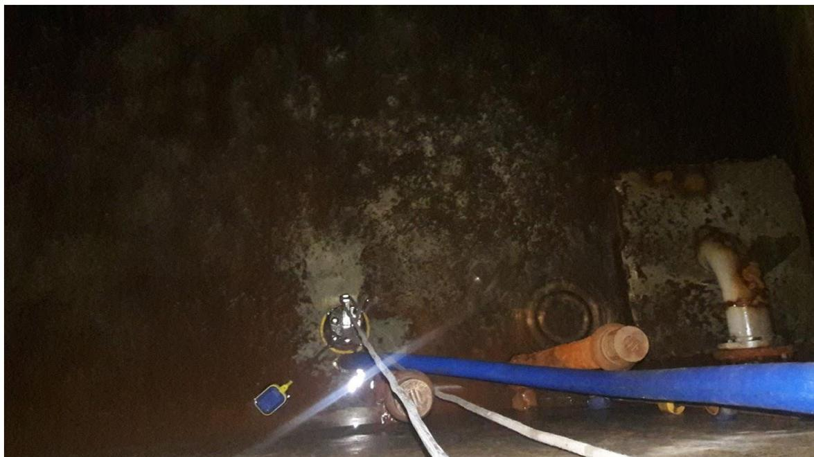
**Figura 23.** Retirando el agua de la cisterna contra incendio
