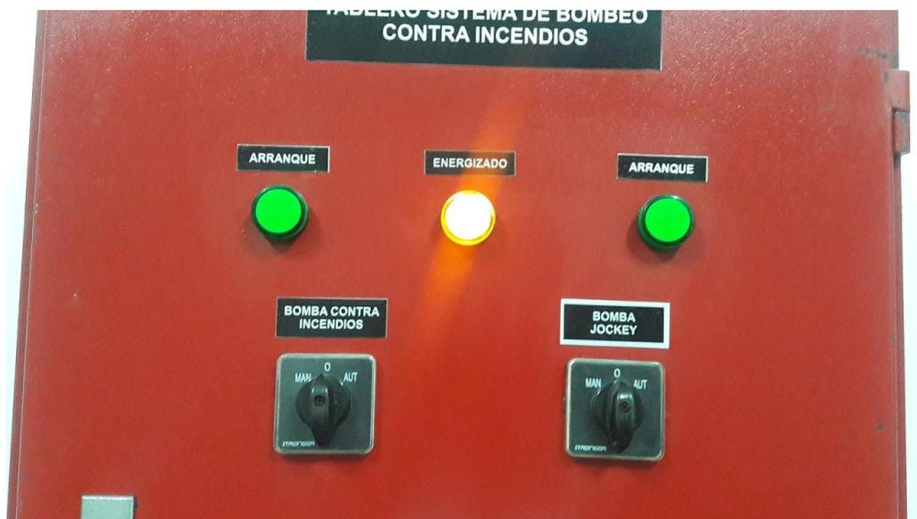
**Figura 22.** Tablero Automatizado de Cisterna Contra Incendio
