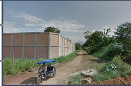
ENTRADA DESDE LA VÍA DE EVITAMIENTO CDRA. 20
