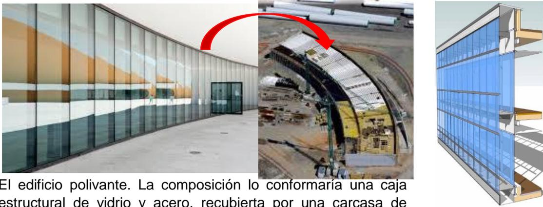
El edificio polivalente. La composición lo conformaría una caja estructural de vidrio y acero, recubierta por una carcasa de hormigón armado.
