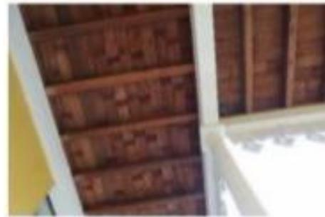
TECHO DE MADERA CON VIGUETAS Y MACHIMBRADO
