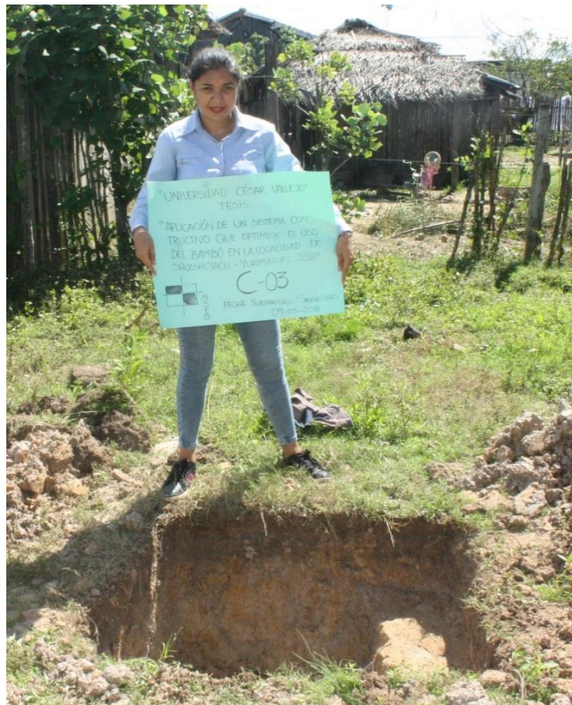
Foto 5: Ejecución de calicata C-03.
