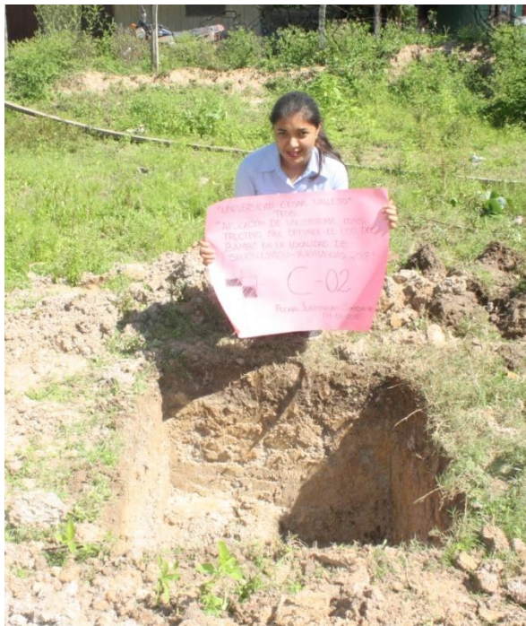
Foto 4: Ejecución de calicata C-02.
