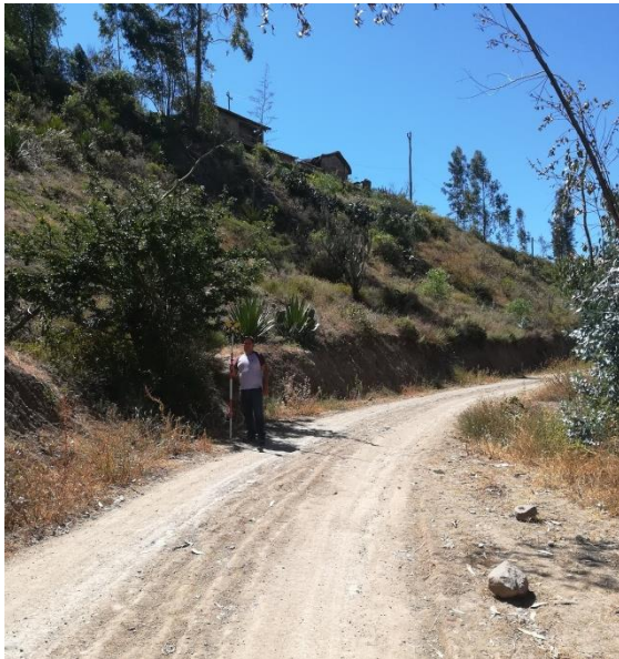
Ayudante de topografía junto al prisma para realizar el levantamiento topográfico de la carretera a diseñar.
