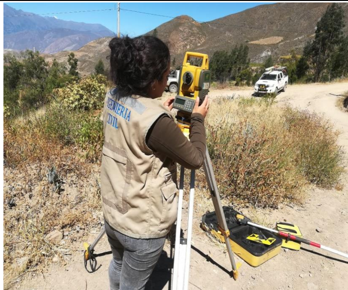
Manipulación de la estación total para realizar el levantamiento topográfico.
