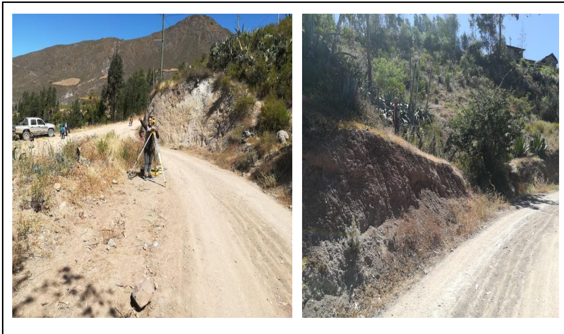
Realizando el levantamiento topográfico utilizando estación total y prisma.
