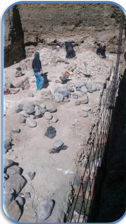
Gráfico N°04: Terreno en proceso constructivo desde cimentaciones, excavación por zanjas.
