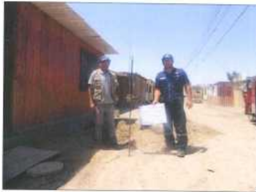
FOTO 11: SE OBSERVA UNA VISTA PANORAMICA DEL ENSAYO DE PENETRACION LIGERA DPL-01
