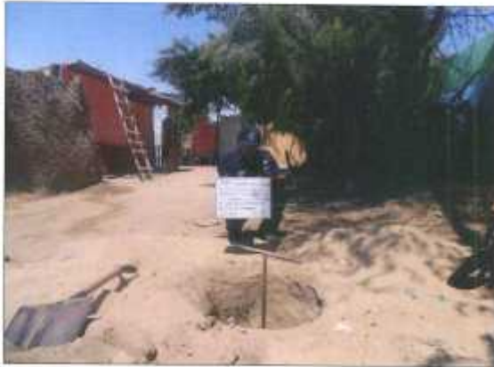
FOTOS 08: SE OBSERVA UNA VISTA PANORÁMICA DE LA EXCAVACION DE LA CALICATA C-04.
