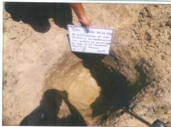
FOTO 03: SE OBSERVA LA EXCAVACIÓN CALICATA C-02.
