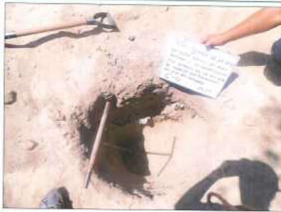
FOTO 07: SE OBSERVA LA EXCAVACIÓN CALICATA C-04.
