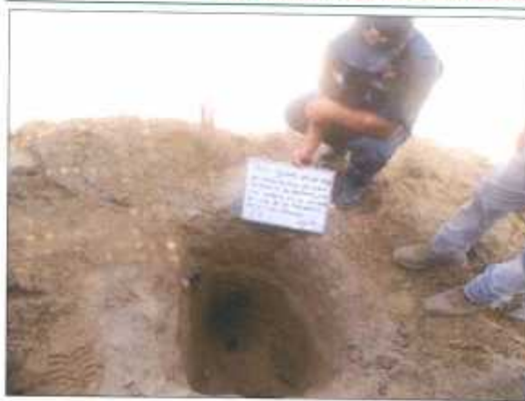
FOTO 01: SE OBSERVA LA EXCAVACIÓN CALICATA C-01.
