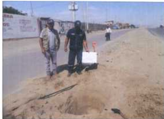
FOTOS 10: SE OBSERVA UNA VISTA PANORÁMICA DE LA EXCAVACION DE LA CALICATA C-05.
