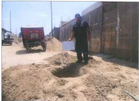
FOTOS 06: SE OBSERVA UNA VISTA PANORÁMICA DE LA EXCAVACION DE LA CALICATA C-03.
