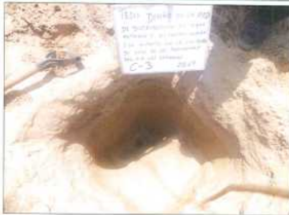
FOTO 05: SE OBSERVA LA EXCAVACIÓN CALICATA C-03.
