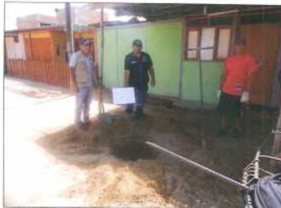
FOTOS 02: SE OBSERVA UNA VISTA PANORÁMICA DE LA EXCAVACION DE LA CALICATA C-01.
