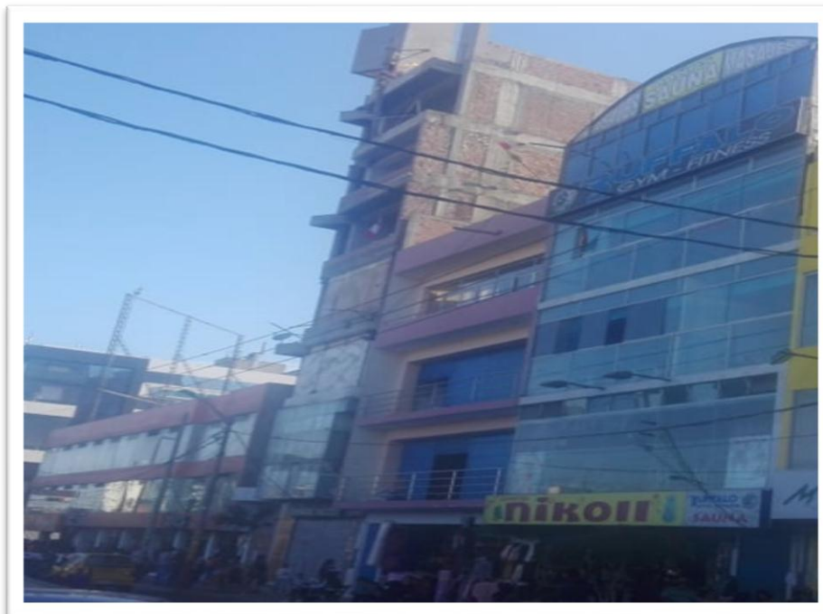
Figura N°2. Edificio de Concreto Armado (Inversiones Cubas)
