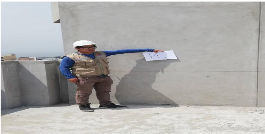
FIGURA N° 2 Muro estructural N°2
