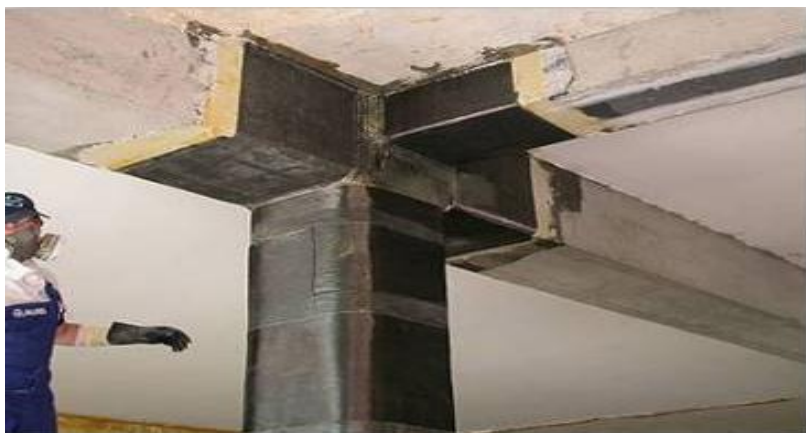
FIGURA N° 27 Encamisado con fibras de carbono
