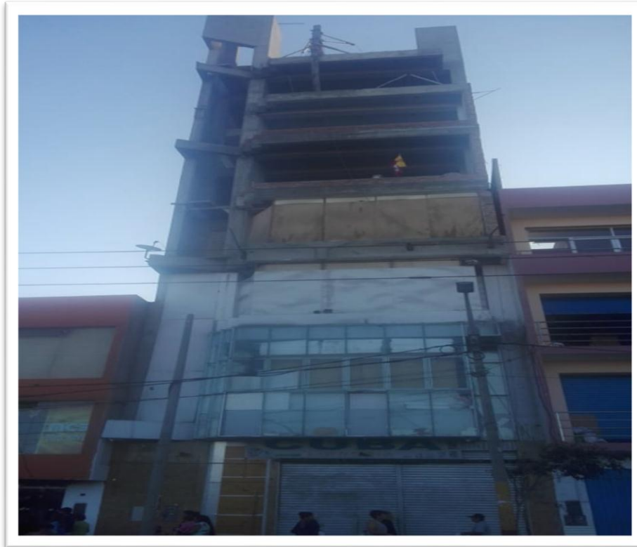
Figura N°1. Edificio de Concreto Armado (Inversiones Cubas)
