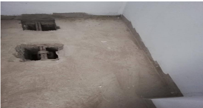
FIGURA N°6 Losa del Nivel N°5
