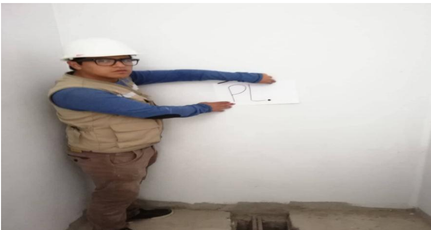
FIGURA N°4 Muro estructural N°3
