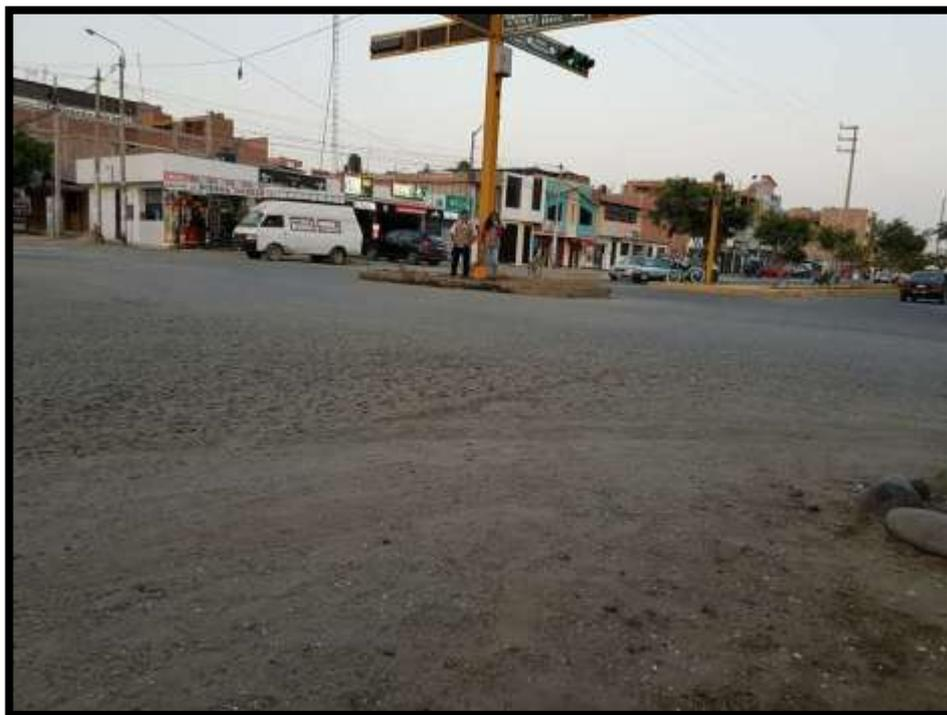
Imagen 08. Falta de señalización de tránsito vertical y horizontal, y zonas peatonales en la intersección de la Av. Universitaria con la Av. Brasil.
