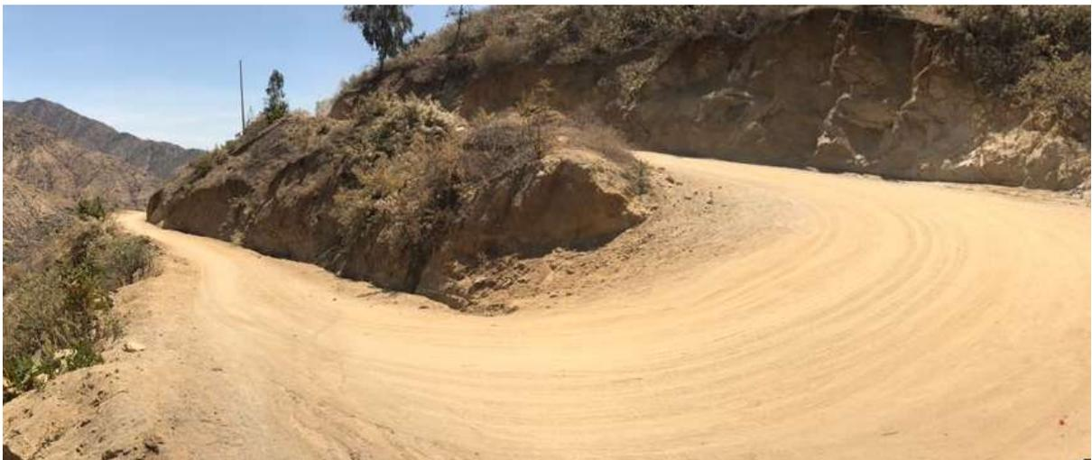
**FOTO N°2:** Se puede apreciar la combinación de curva horizontal y vertical del camino vecinal
