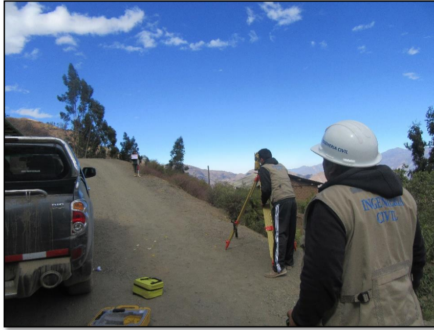
Ilustración N° 3: Levantamiento con estación total.
