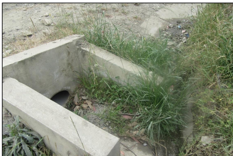
Ilustración N° 9: Se aprecia la alcantarilla de concreto de sección circular.
