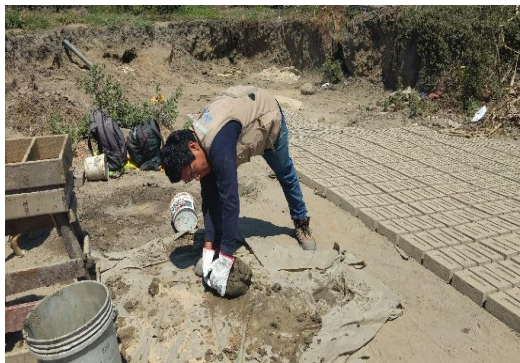
FIGURA N° 37, N°38, N°39, N°40: Colocación de un solo golpe la mezcla en la gavera y retiro de material excedente.
