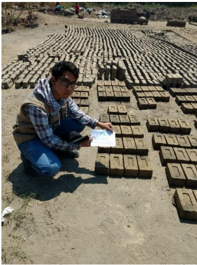
FIGURA N°49: Volteo de los ladrillos de arcilla artesanal y con adición de 6%,12%, 18%,24% de vidrio triturado reciclado después de tres días para su secado uniforme en todas sus caras.
