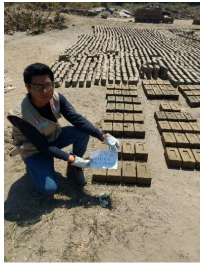
FIGURA N°49: Volteo de los ladrillos de arcilla artesanal y con adición de 6%,12%, 18%,24% de vidrio triturado reciclado después de tres días para su secado uniforme en todas sus caras.
