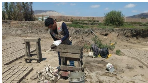
FIGURA N°41, N°42, N°43, N°44: Con ayuda de una cortadora retirando lo excedente en la gavera y desmolde de los ladrillos con vidrio triturado reciclado en un terreno firme(tendales) para su respectivo secado.
