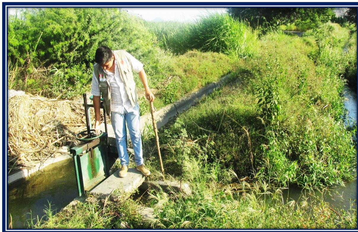
Fig. 16. Compuertas laterales para los Usuarios.
