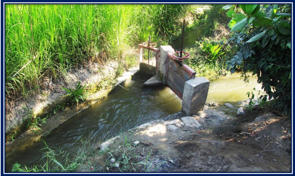
**Fig. 14.** Compuertas laterales para los Usuarios.
