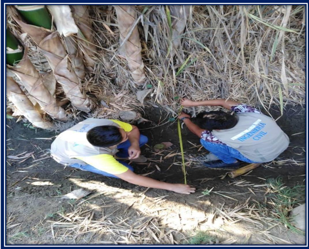
Fig. 34. Aforamiento en el Canal L2.
