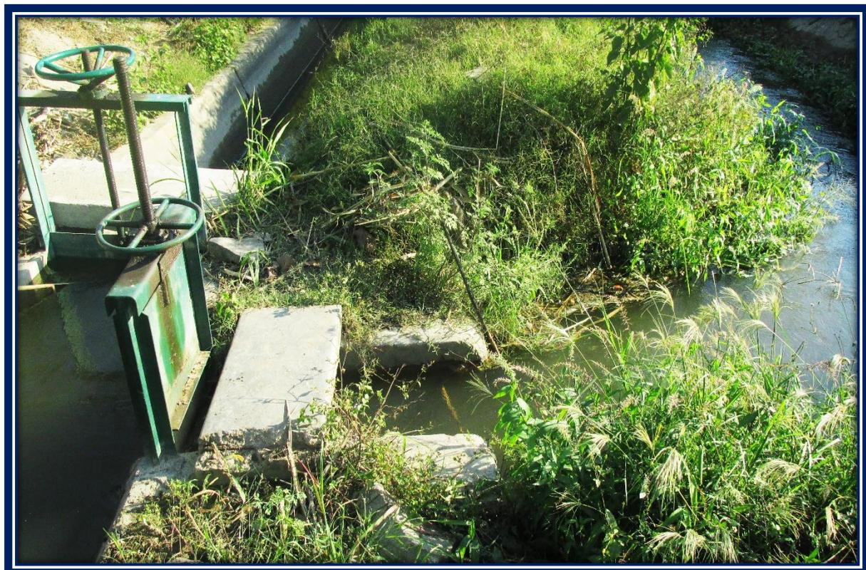
Fig. 19. Compuertas laterales para los Usuarios.
