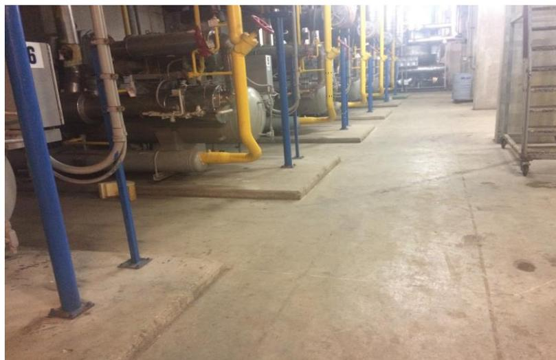
**Figura 07:** Compresores de tornillo de refrigeración (mycom)
