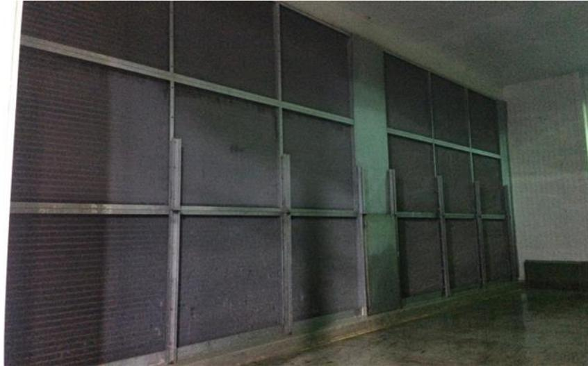
*Figura 17: Verificación de evaporadores limpios de escarcha*
