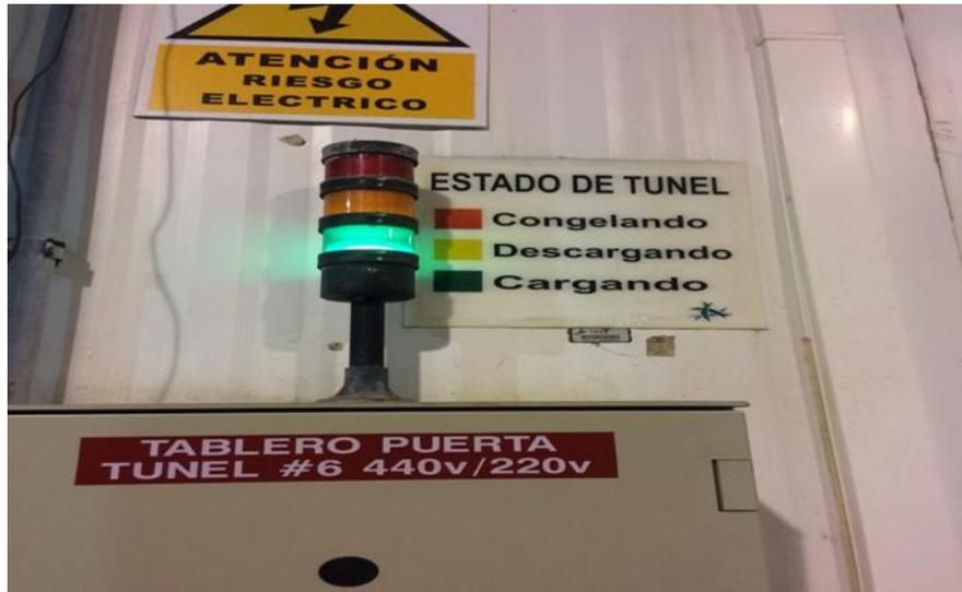
**Figura 20:** Luces de señalización túneles
