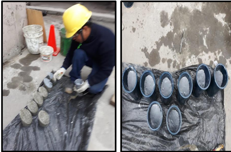
Figura 4 y 5. Aplicación del Adhesivo epóxico.
