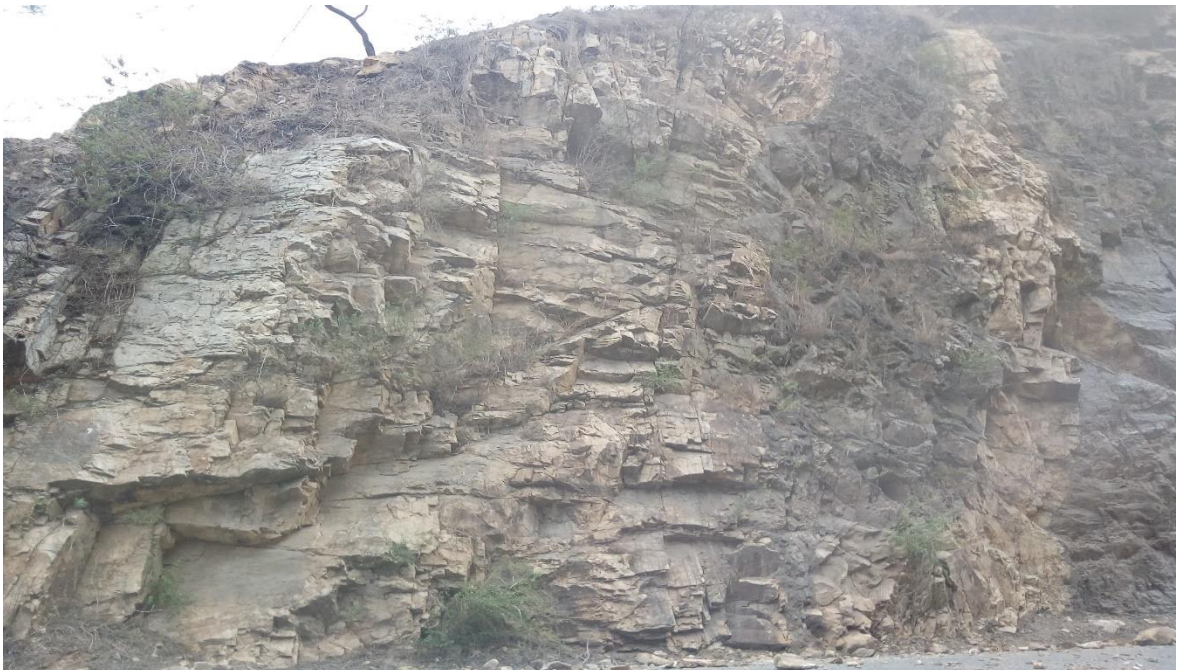
Anexo 222 Taludes en el sector La Pilca. Fuente: Propia.
