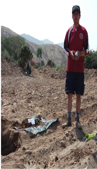
FOTO 11- Realización de la calicata 4
