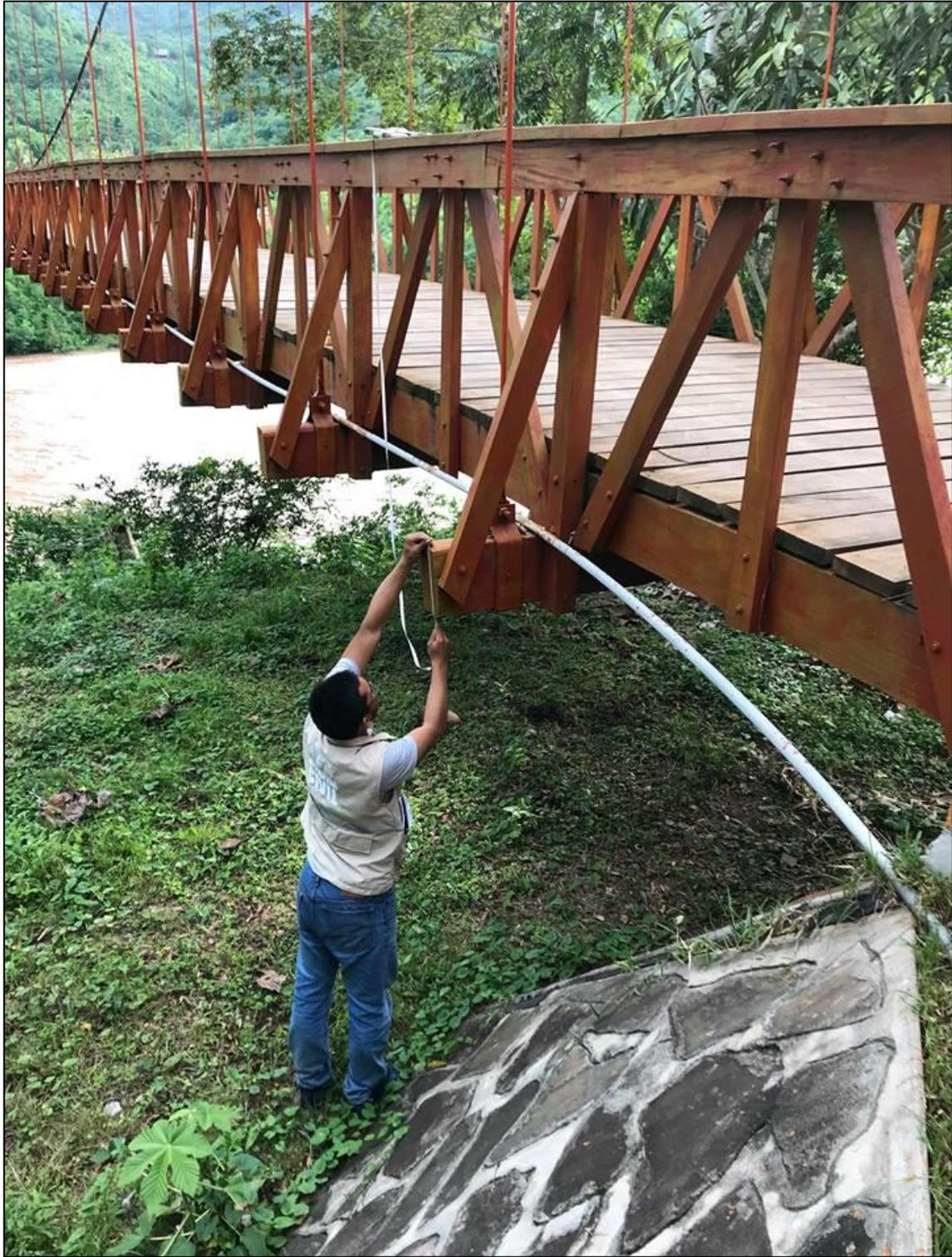
Foto 05: Verificación de viga transversal de sección 5"x10"
