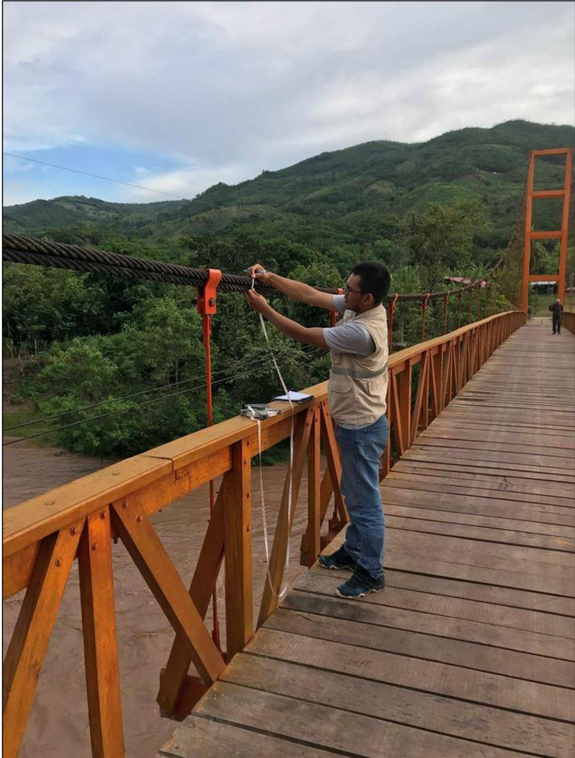
Foto 07: Verificación de diámetro de cable tipo boa 6x19, diámetro 1 5/8"
