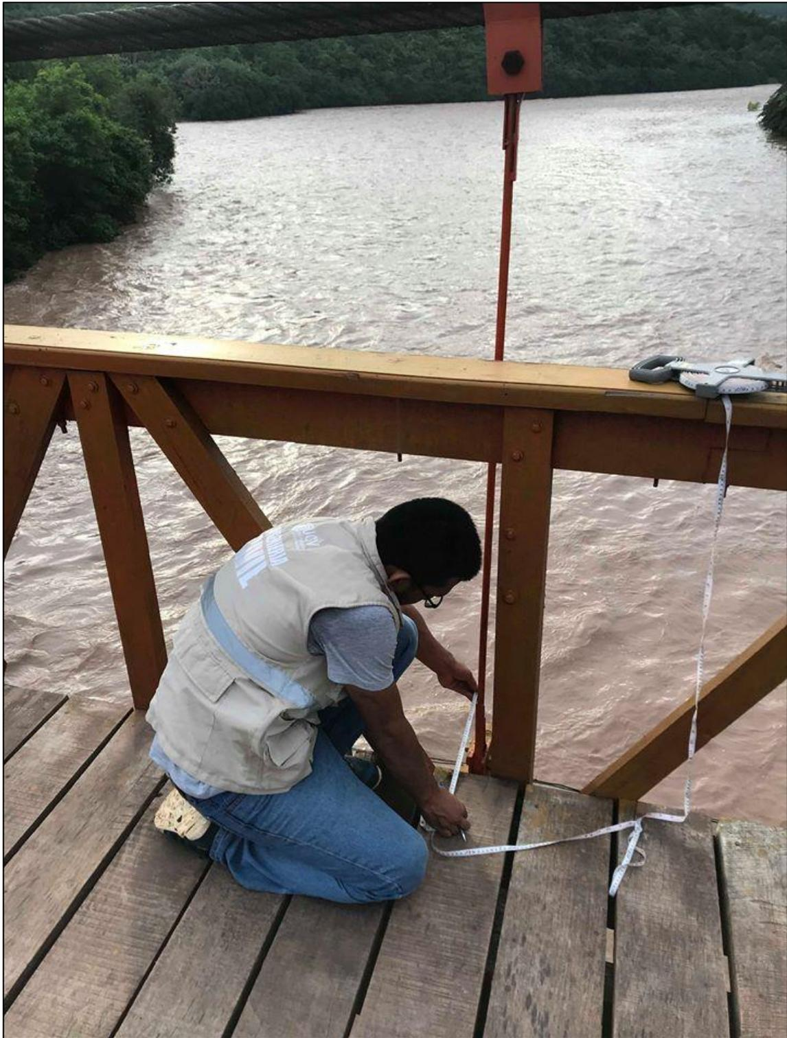
Foto 09: Verificación de distancia entre eje de viga longitudinal exterior a eje de péndola, es conforme 0.325 metros.
