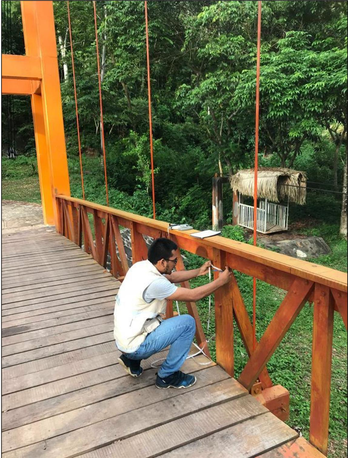
Foto 08: Verificación de montantes principales, sección 4" x 4".
