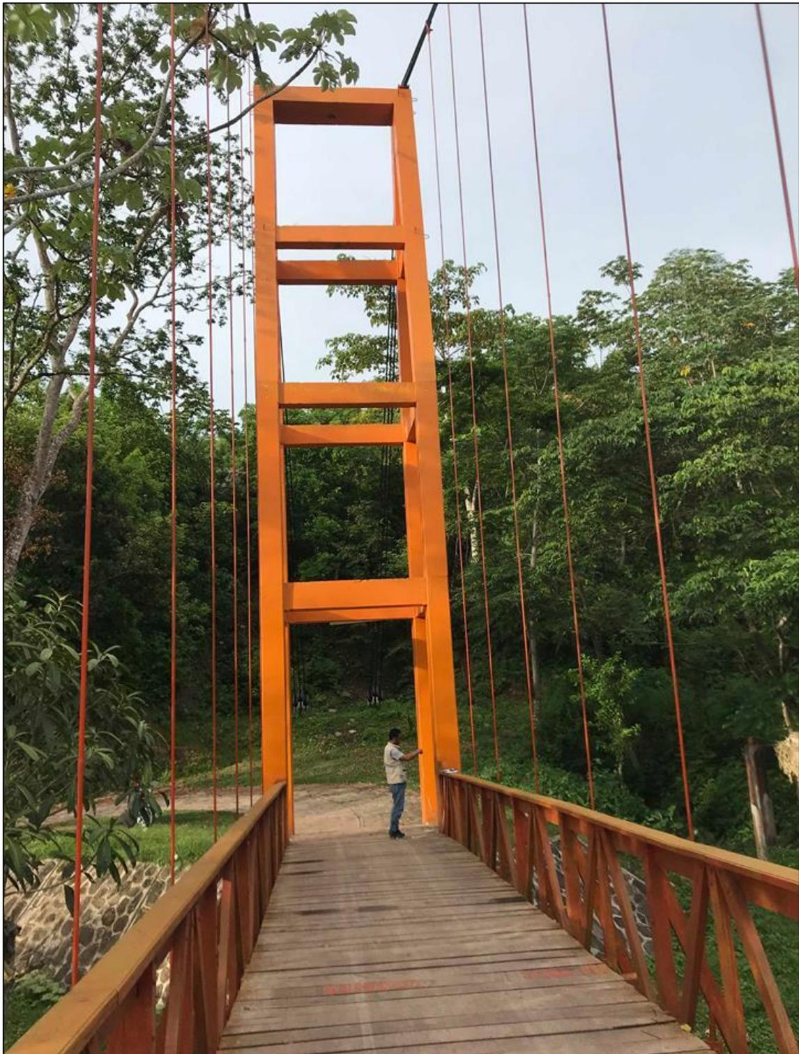
Foto 03: Verificación de las columnas de la torre izquierda C-50x40 cm
