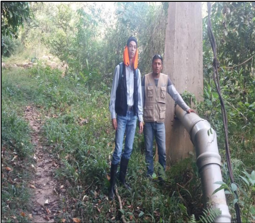
Vista de pase aéreo de la línea de conducción que se dio en el reconocimiento del área donde se realizará la obtención de datos para el proyecto de investigación.
