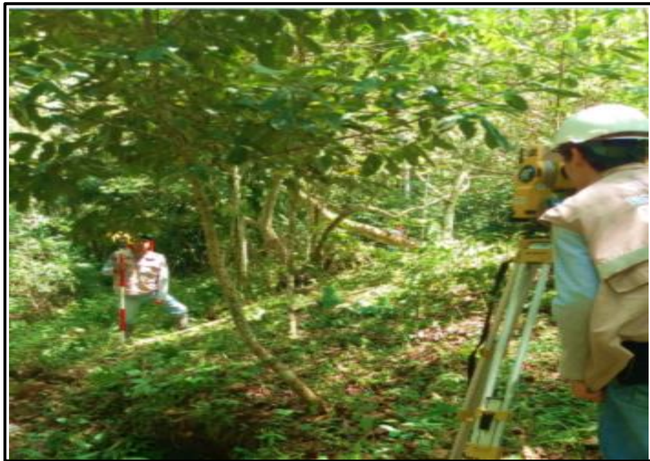
Vista de levantamiento topográfico en la quebrada Rumiyaçu.
