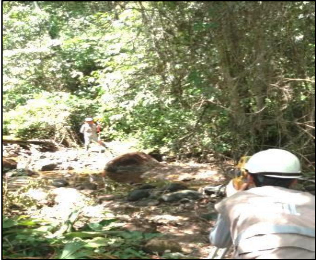
Vista de levantamiento topográfico en la quebrada Rumiycu en terren
