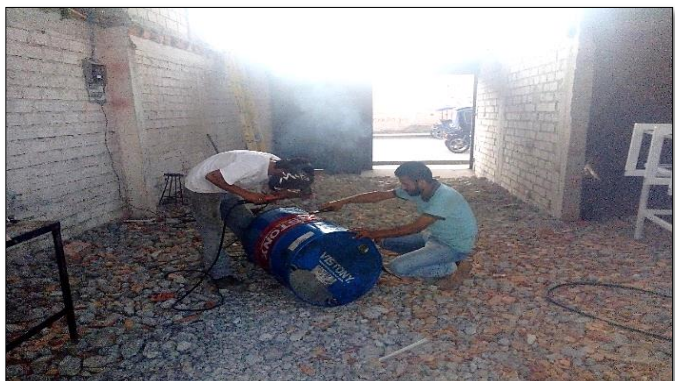
Ilustración 11. Construcción de horno artesanal
