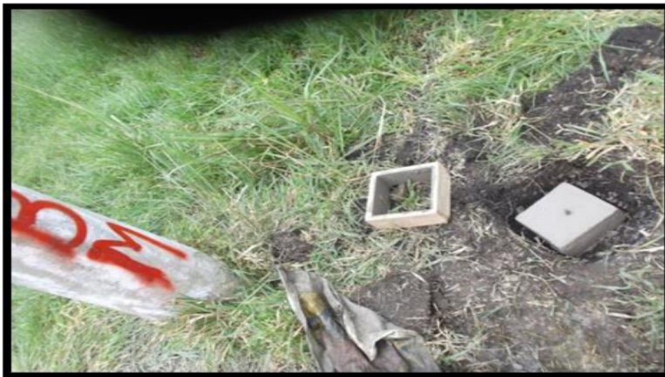
FOTO N° 02: Se observa punto de referencia (BM).
