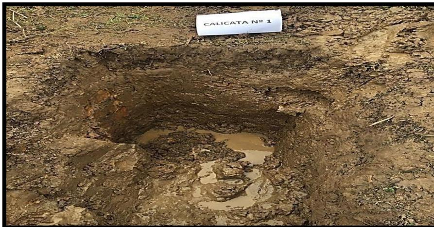
**Foto N°07.** Excavación de calicata para los estudios de suelo.
