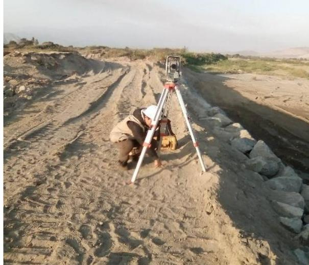
Se marcó el punto de estación para comenzar el levantamiento topográfico
