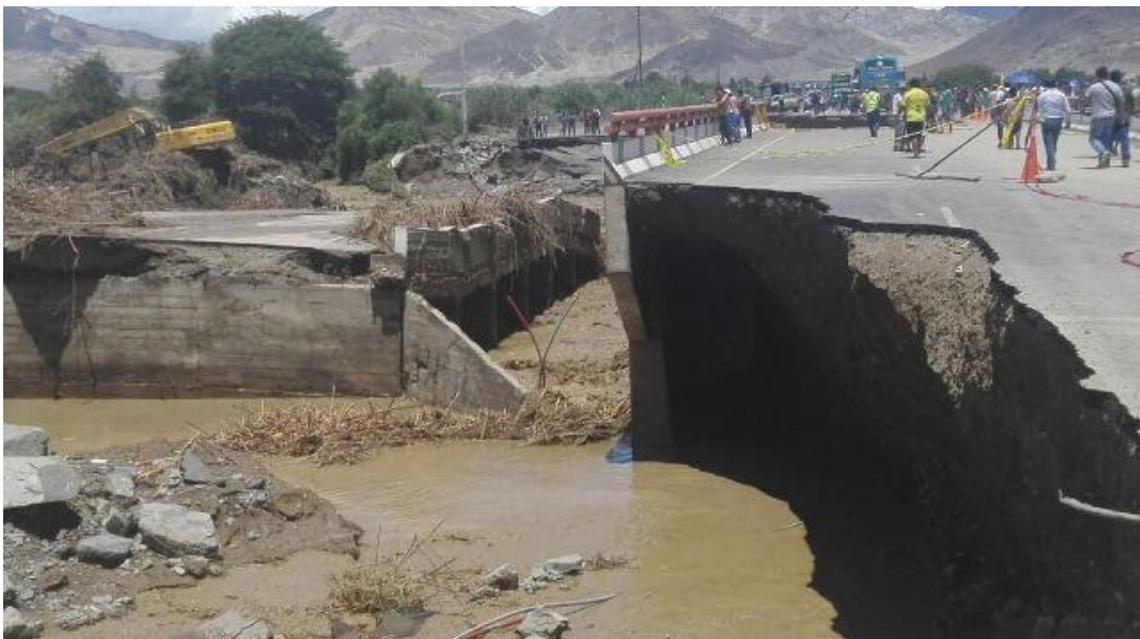
Puente Huambacho en mal estado por las causas de la socavación
