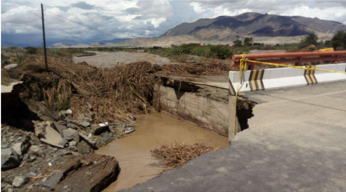
Puente Huambacho donde se observa la colmatación que tuvo en el estribo izquierdo obligando a que la corriente se desplace al lado derecho del río
