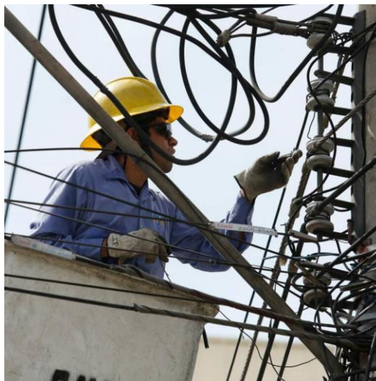
Imágen 1 . visual inspection of insulators
