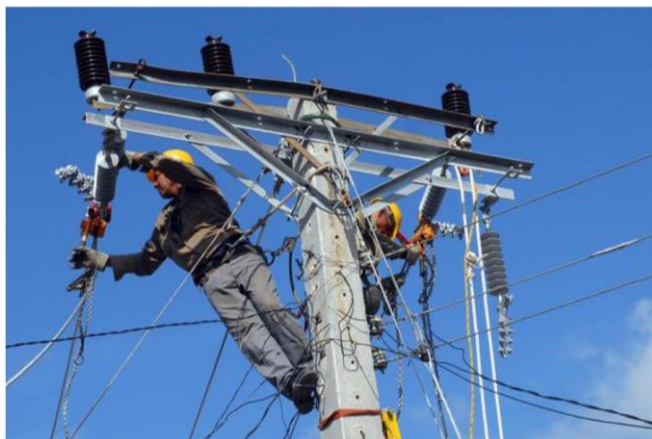
Imágen 8 Ejecución de revisión de Torre eléctrica
