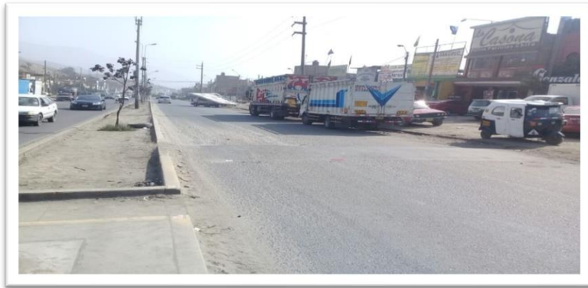
Figura 1: Se muestra una carpeta asfáltica
