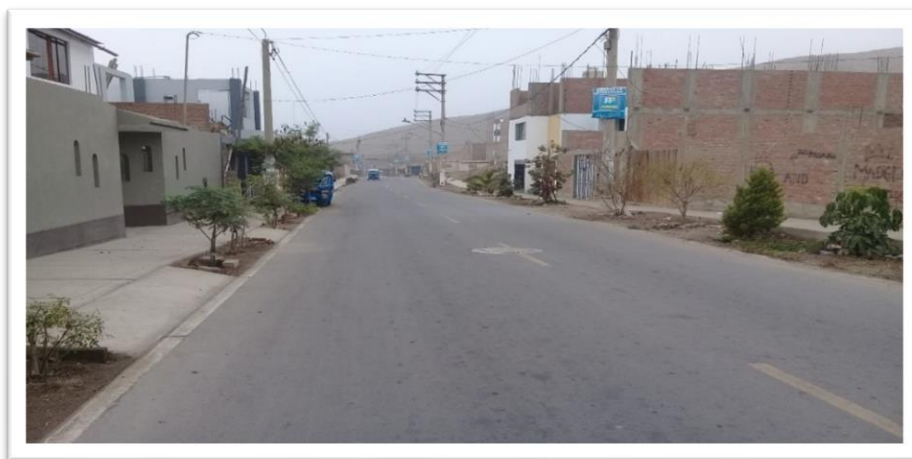
Figura 2: Se aprecia la aplicación de micro pavimento
