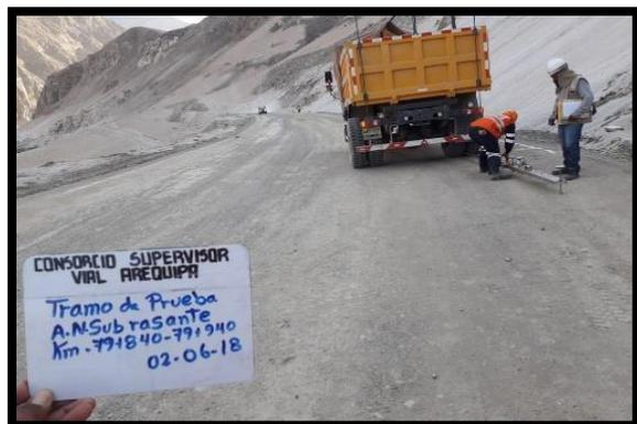
Figura 45. Ensayo de deflectometría km. 79+840 - 79+940
