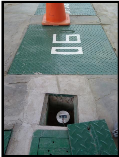
Figura 9: Imagen de tanque gasolina 90 con sensor ultrasónico
