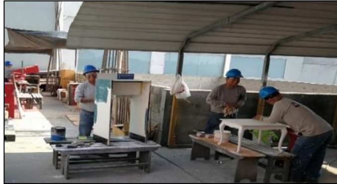
Gráfico 8: Trabajos en el área de pintores
