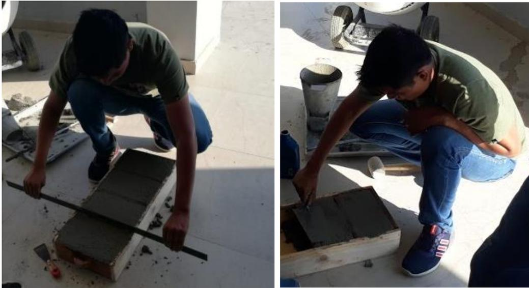
Se enrazo el molde de madera con la ayuda de una regla de aluminio, luego con la ayuda de una plancha de dio el pulido de la superficie de la unidad.
