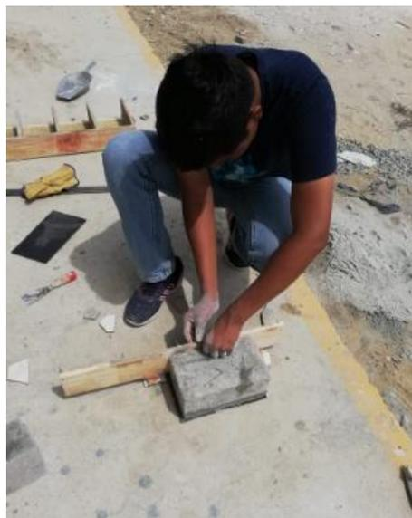
A las 24 horas se procedió con el desencofrado de las unidades de albañilería para posteriormente pasar al proceso de curado.
