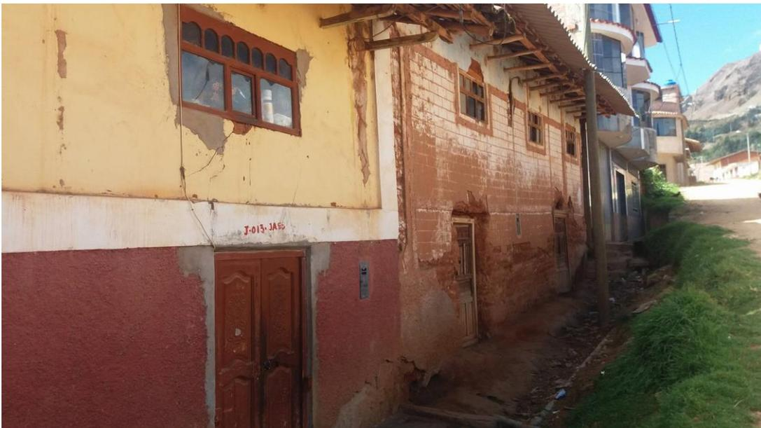
**Foto 2: Fachadas en mal estado por la etapa de explosión producida por la minera “el Toro”**
