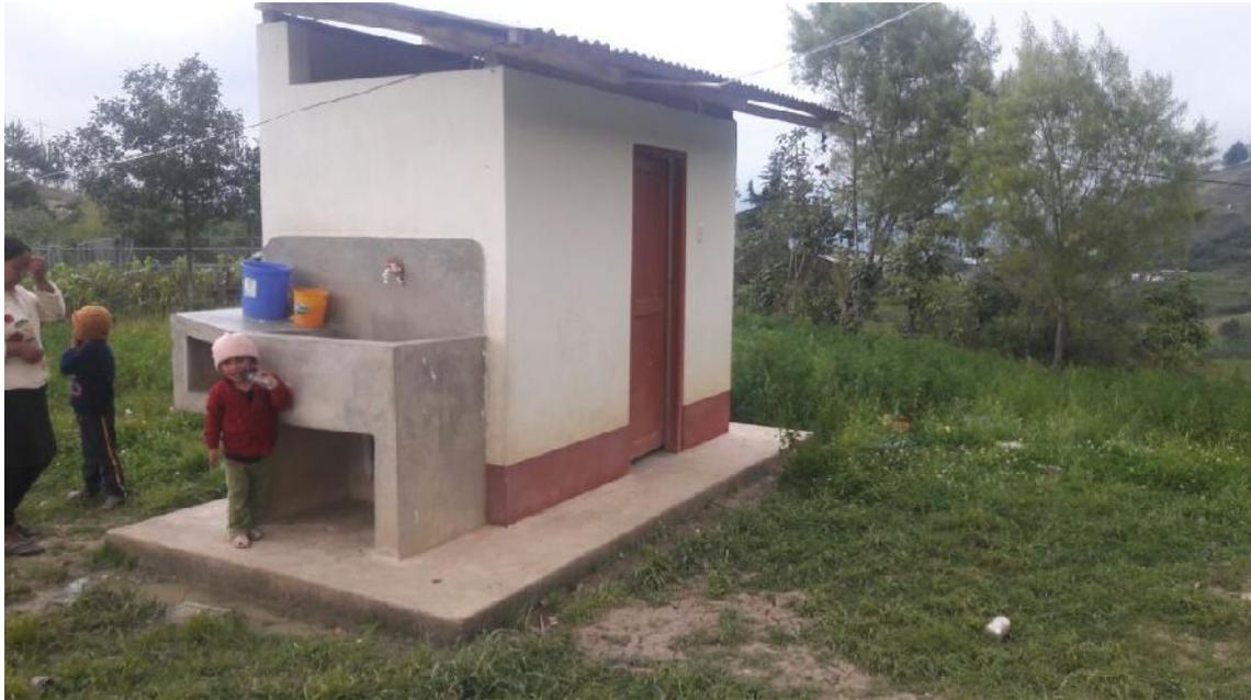
En esta imagen se puede observar una unidad básica de saneamiento (UBS), en la cual se aprecia un lavadero en la parte exterior, en la parte interior consta de un inodoro, un lavatorio y una ducha.
