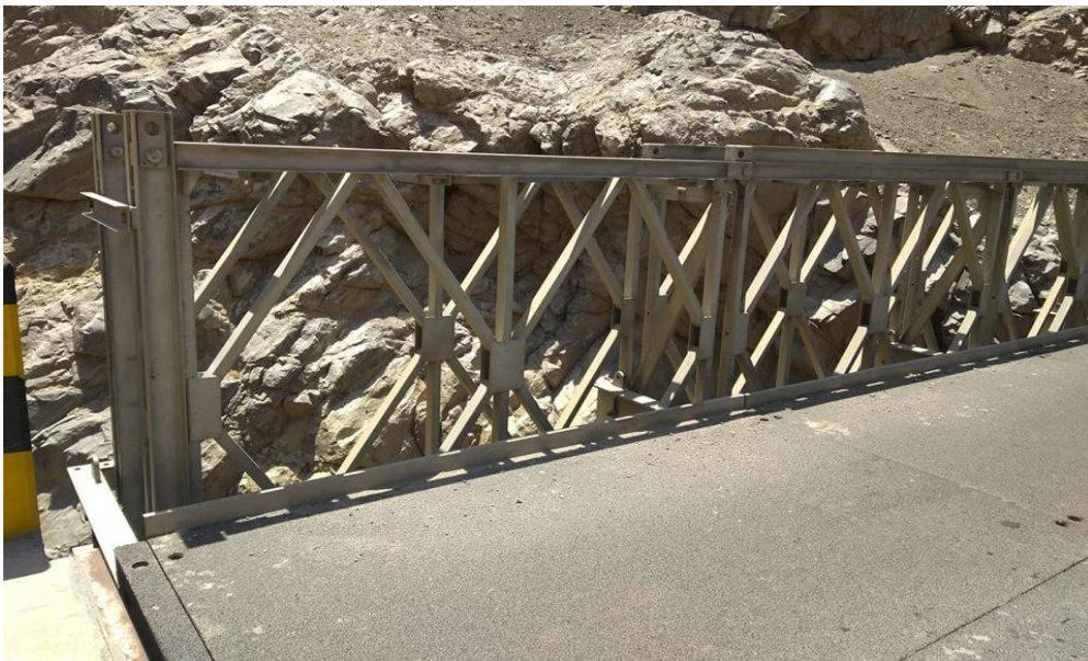
Imagen 8: En la siguiente imagen se percibe la super estructura, en donde se entiende a través de las fichas de inspección que se tiene, como las diferentes partes metálicas que tiene el puente como el emparrillado, bastidor de arriostramiento, panel Bailey y el travesero cada uno con sus respectivas piezas, observando a través de esta ficha de manera general.
