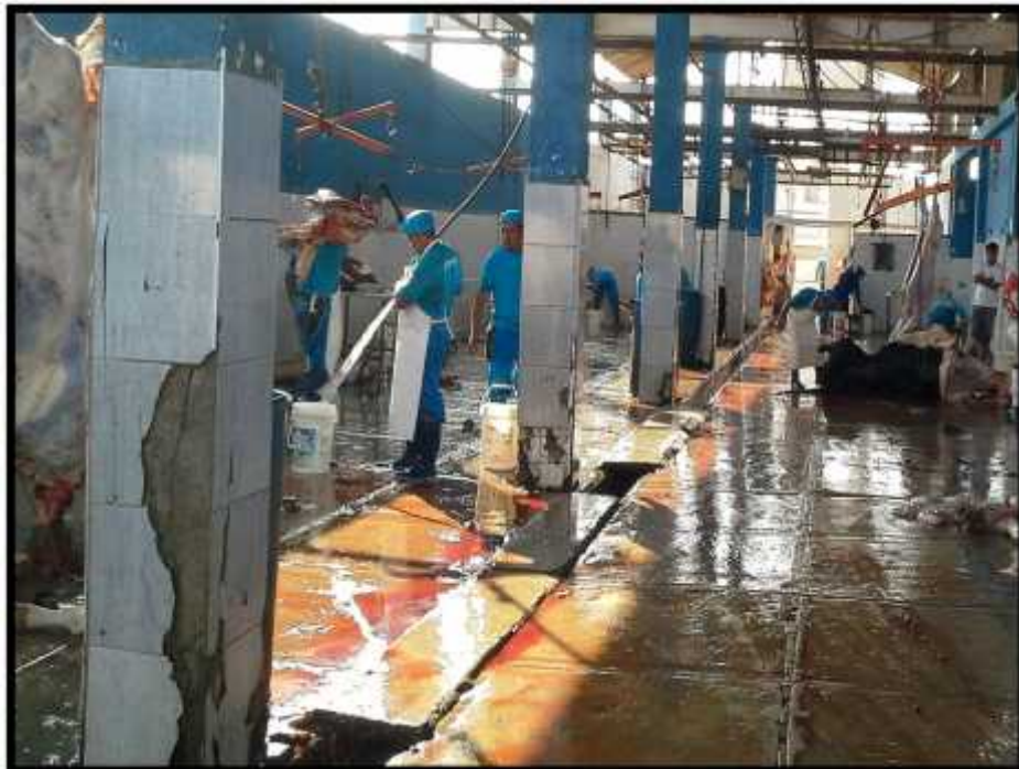
Figura N° 11 Condiciones actuales del Camal Municipal de J.L.O
