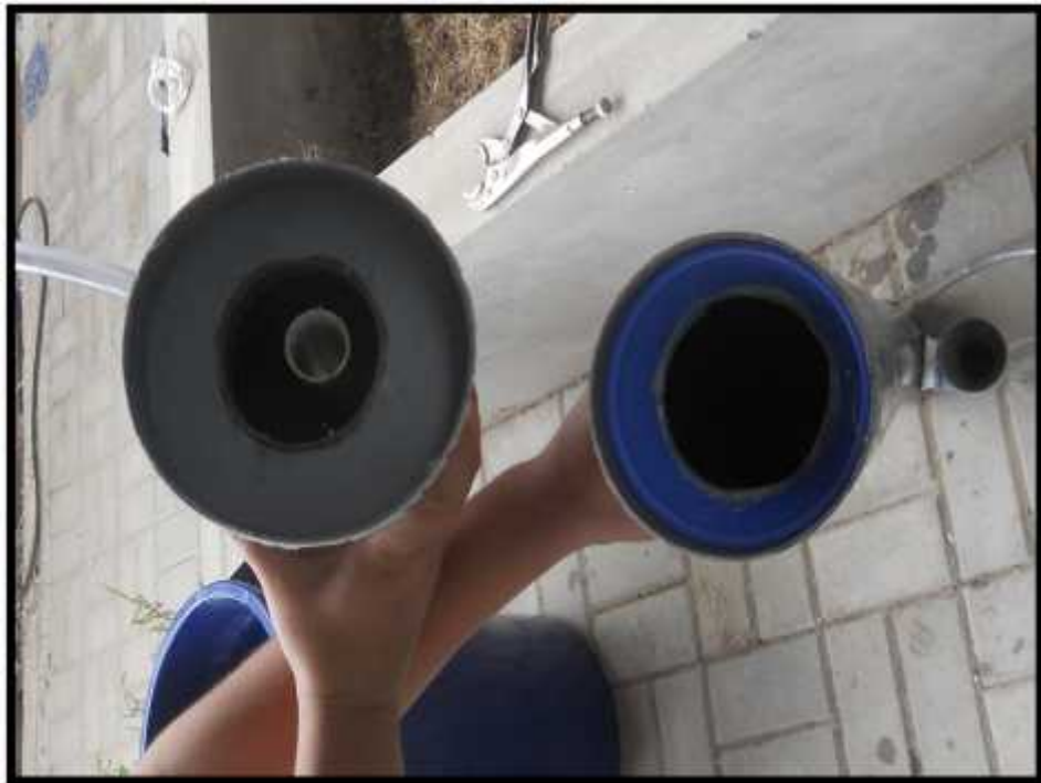
Figura N° 13 Construcción del RAFA, deflector y sedimentador
