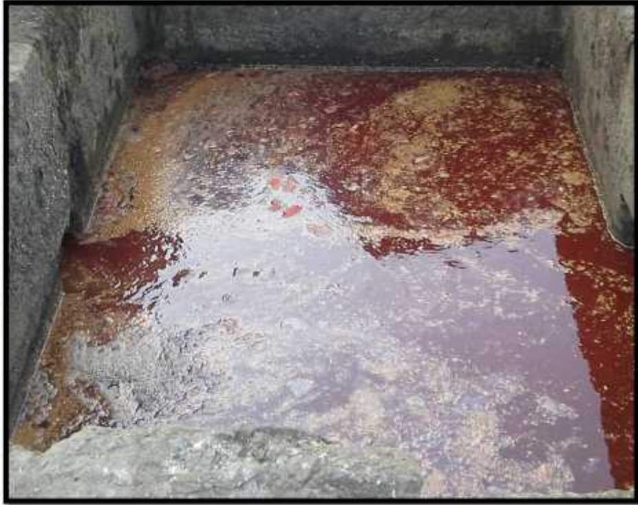
Figura N° 12 Vertidos eliminados en sistema de tratamiento ineficiente
