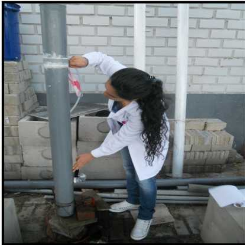
Figura N° 16 Medición Final para verificación del diseño
