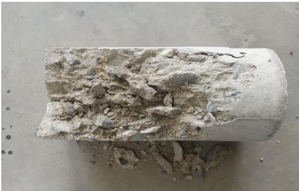
Presenta mala distribución de agregados mayor cantidad de agregado fino no alcanza la resistencia esperada
