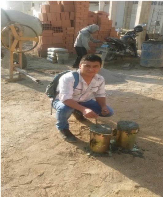
Dos testigos de columnas
