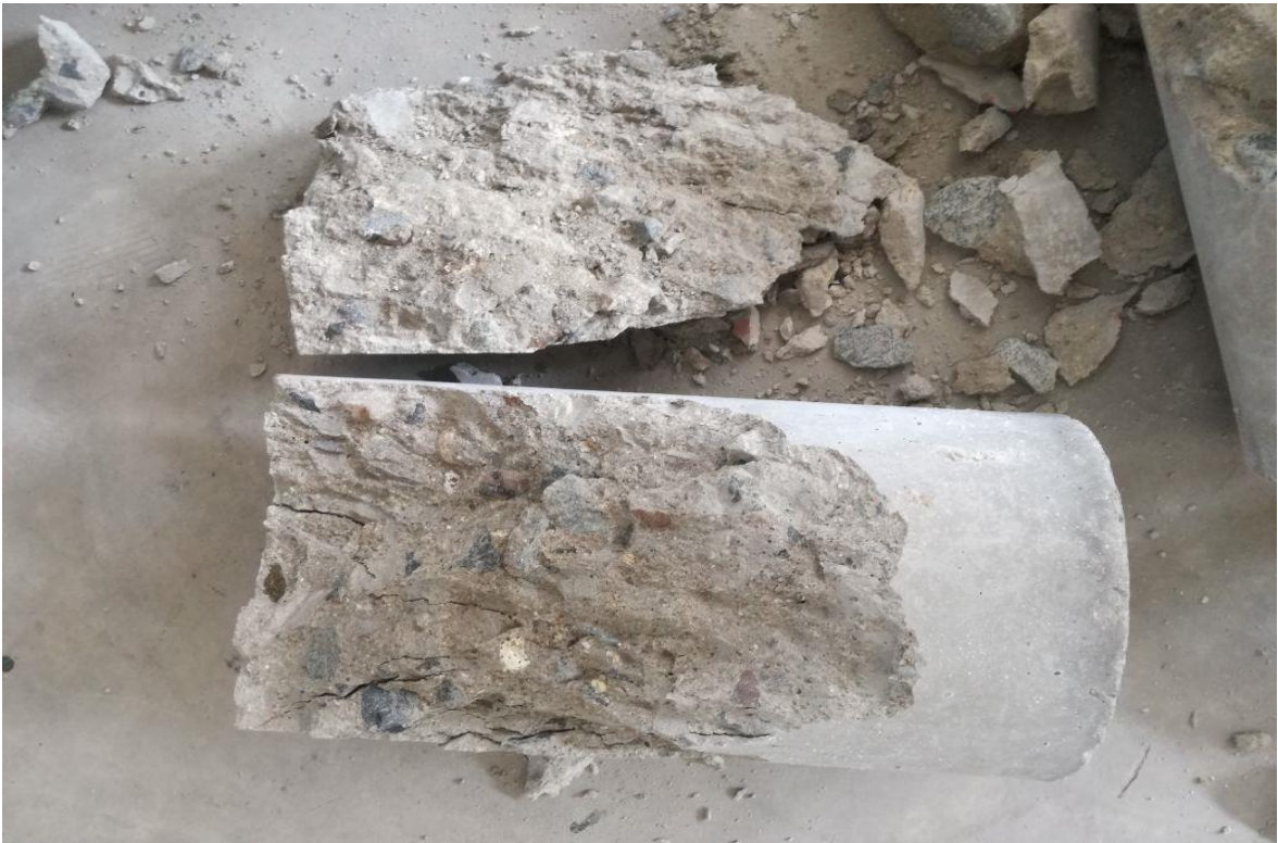
Presenta mala distribución de agregados mayor cantidad de agregado fino como resistencia final baja
