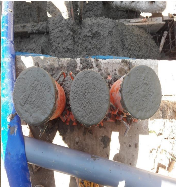
Tres testigos de viga de cimentación
