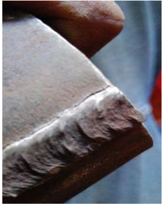
Fisura en lote 3-A
