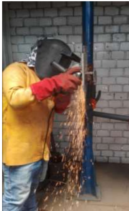
Limpieza del cordón
