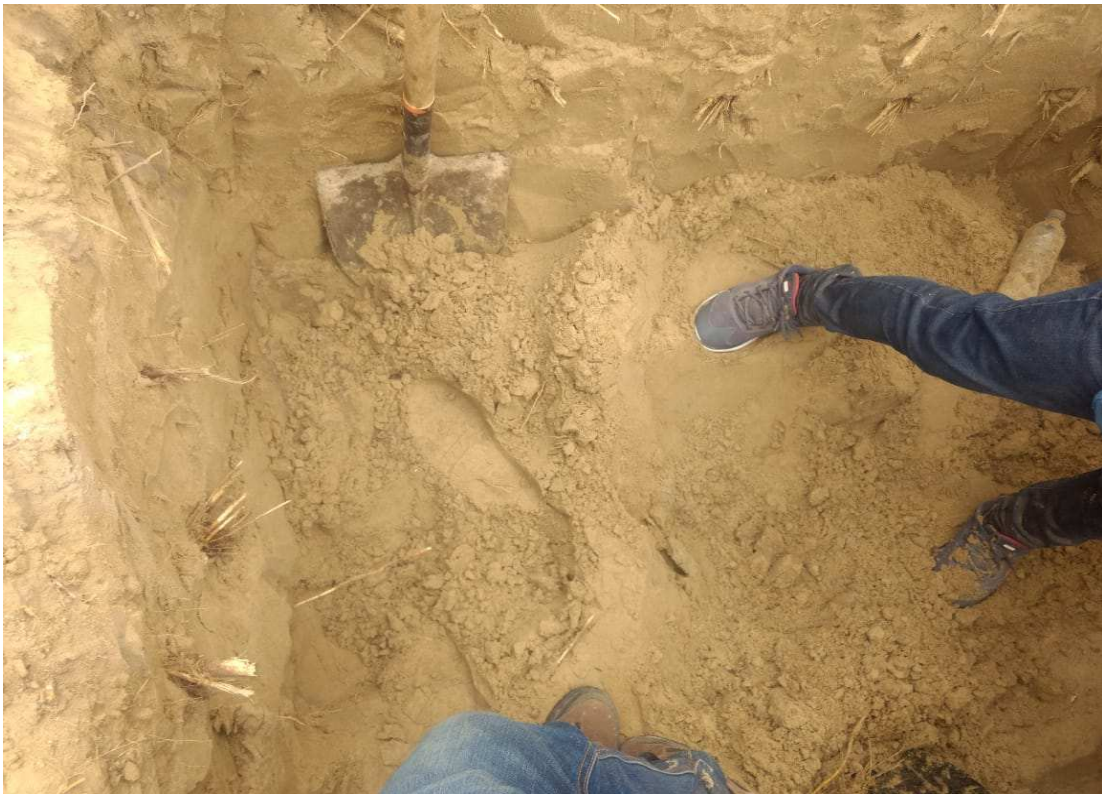
Figura 61. Excavación de la calicata en el Km 0+500.
