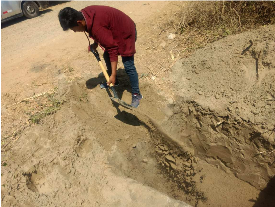
Figura 66. Reposición del material extraído de la calicata en el Km 0+500.
