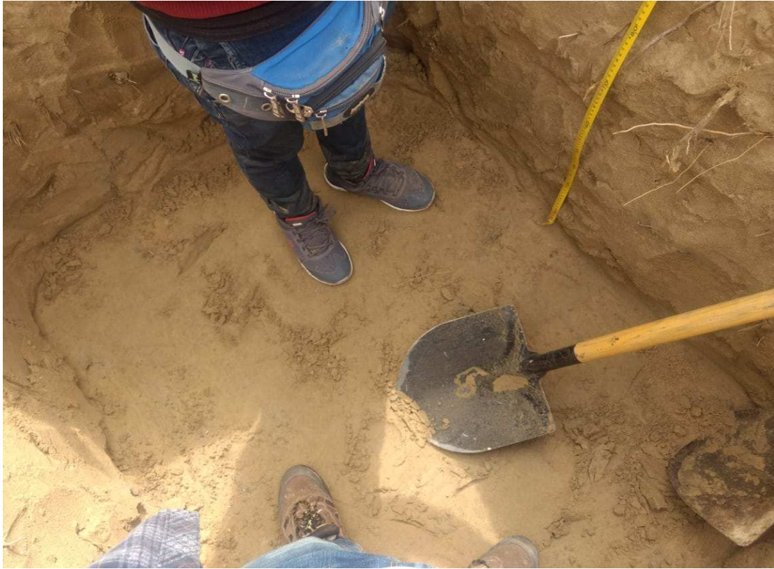
Figura 62. Realización de la calicata de 1.00*1.00*1.50 m.
