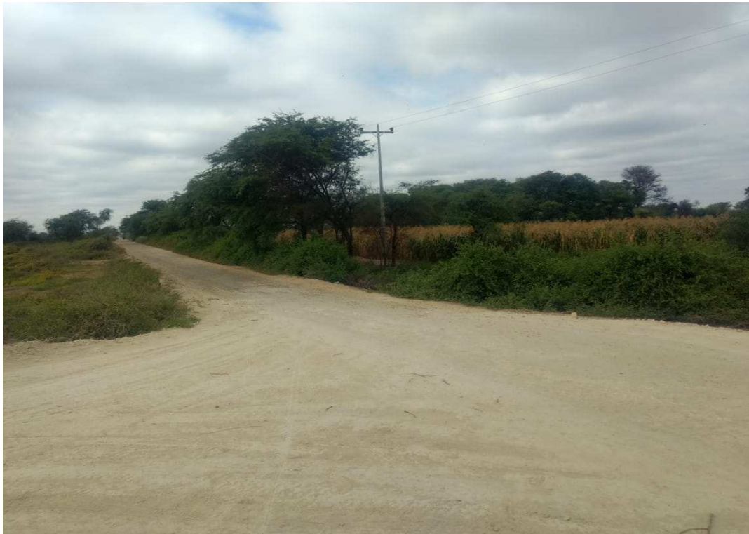
Figura 59. Final del tramo del camino vecinal Buenos Aires, Km 1+000.
