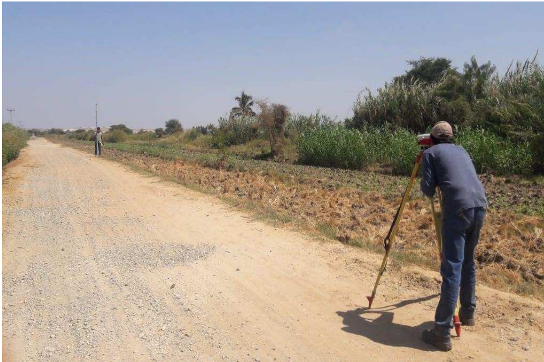
Figura 68. Levantamiento topográfico en el Km 0+500.
