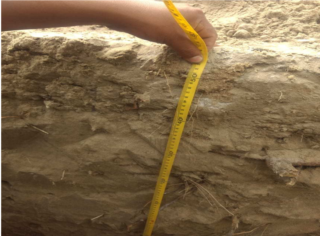
Figura 63. Calicata con una profundidad de 1.50 m.
