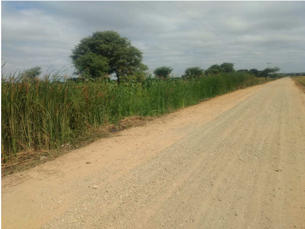
Figura 56. Presencia de vegetación en el camino vecinal Buenos Aires, abcisa 0+550. Fuente: Elaboración Propia, 2018.
