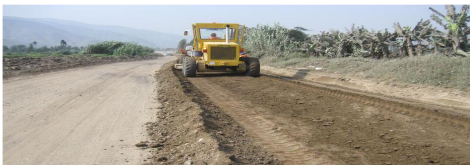
Figura 10: Trabajos de ensanche en carretera
