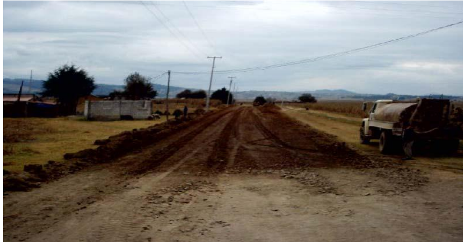
Figura 15: Aplicación de salmuera en campo Fuente: http://picasaweb.google.com/lh/photo2
