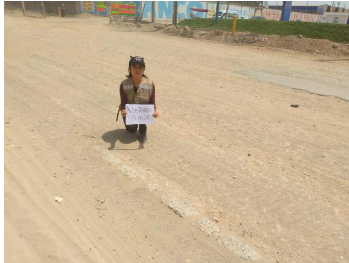
Figura 72. Fijando el punto en las paredes de cada progresiva.
