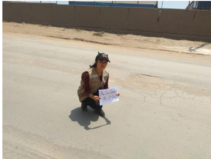
Figura 36. Fijando el punto en las paredes de cada progresiva.
