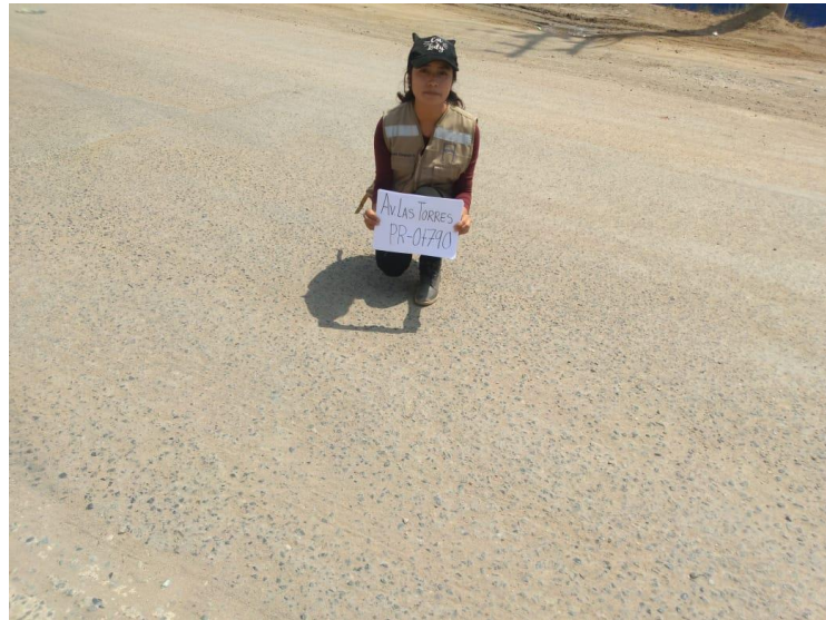
Figura 102. Fijando el punto en el suelo de cada progresiva.
