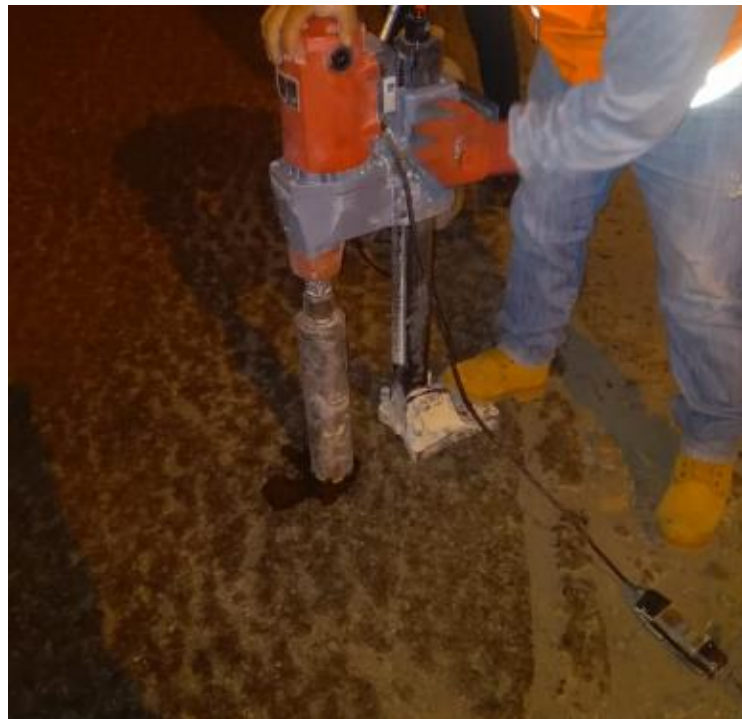
Figura 166. Perforación en asfalto.
