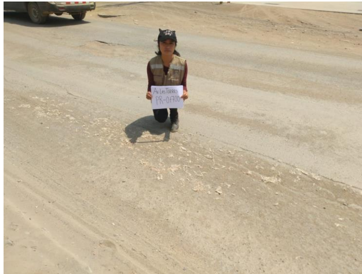
Figura 84. Fijando el punto en las paredes de cada progresiva.
