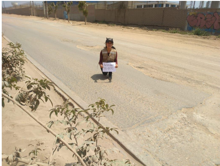
Figura 62. Fijando el punto en las paredes de cada progresiva.
