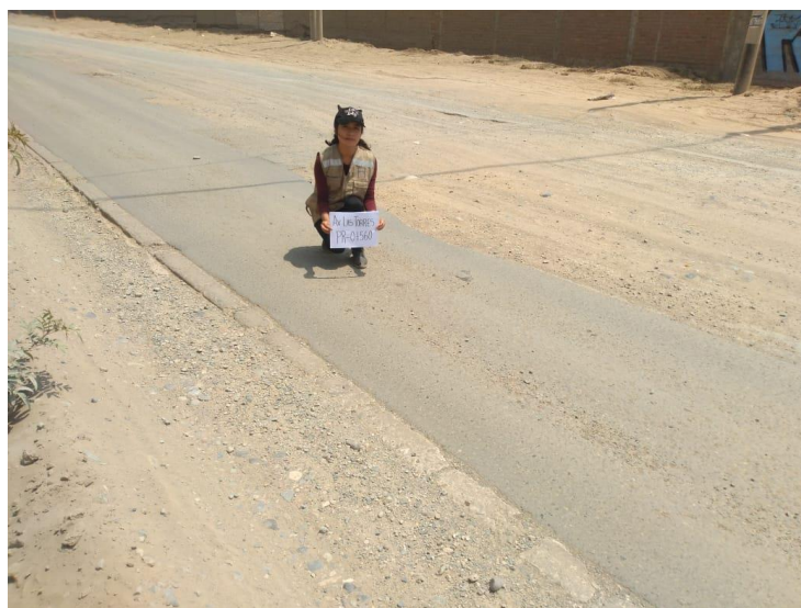
Figura 56. Fijando el punto en las paredes de cada progresiva.
