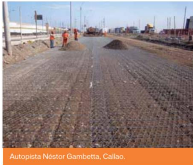
Figura 20. Proyecto con Mesh Track en Autopista Néstor Gambetta, Callao.
