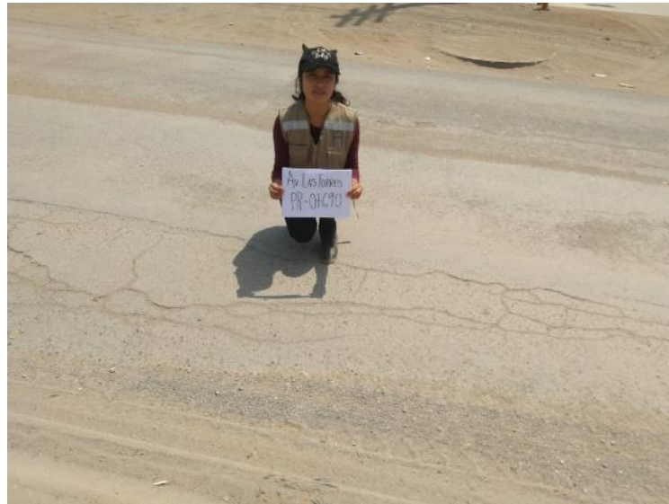
Figura 82. Fijando el punto en las paredes de cada progresiva.
