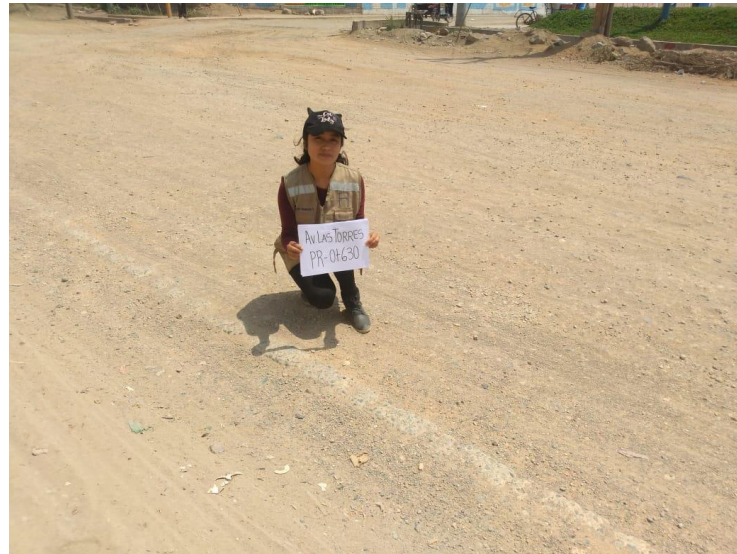
Figura 70. Fijando el punto en las paredes de cada progresiva.
