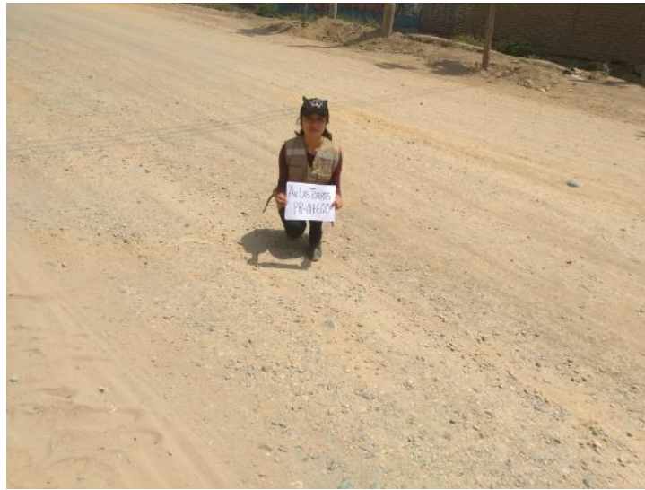
Figura 64. Fijando el punto en las paredes de cada progresiva.
