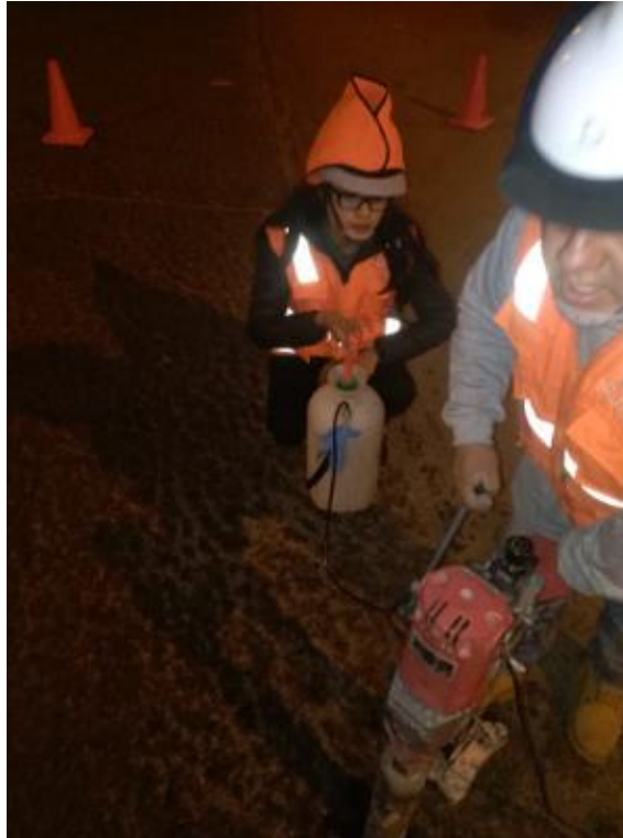
Figura 165. Bombeo de agua.
