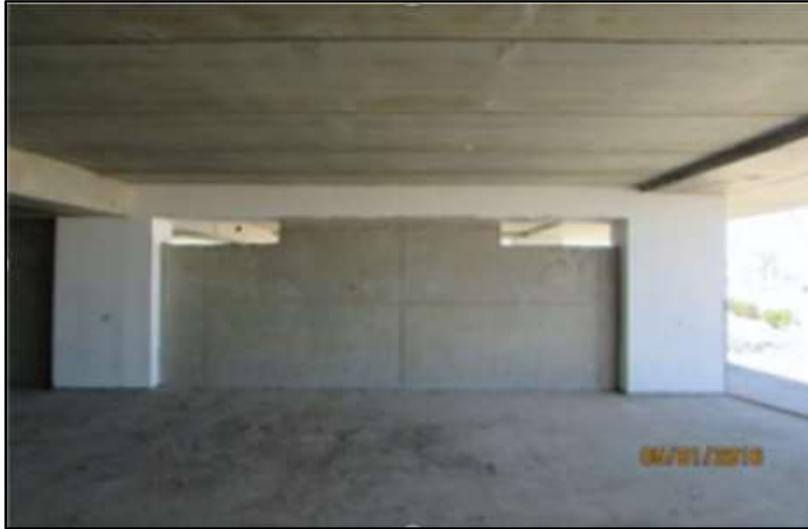
Figura 2. Pantallas o Muros desacoplados
