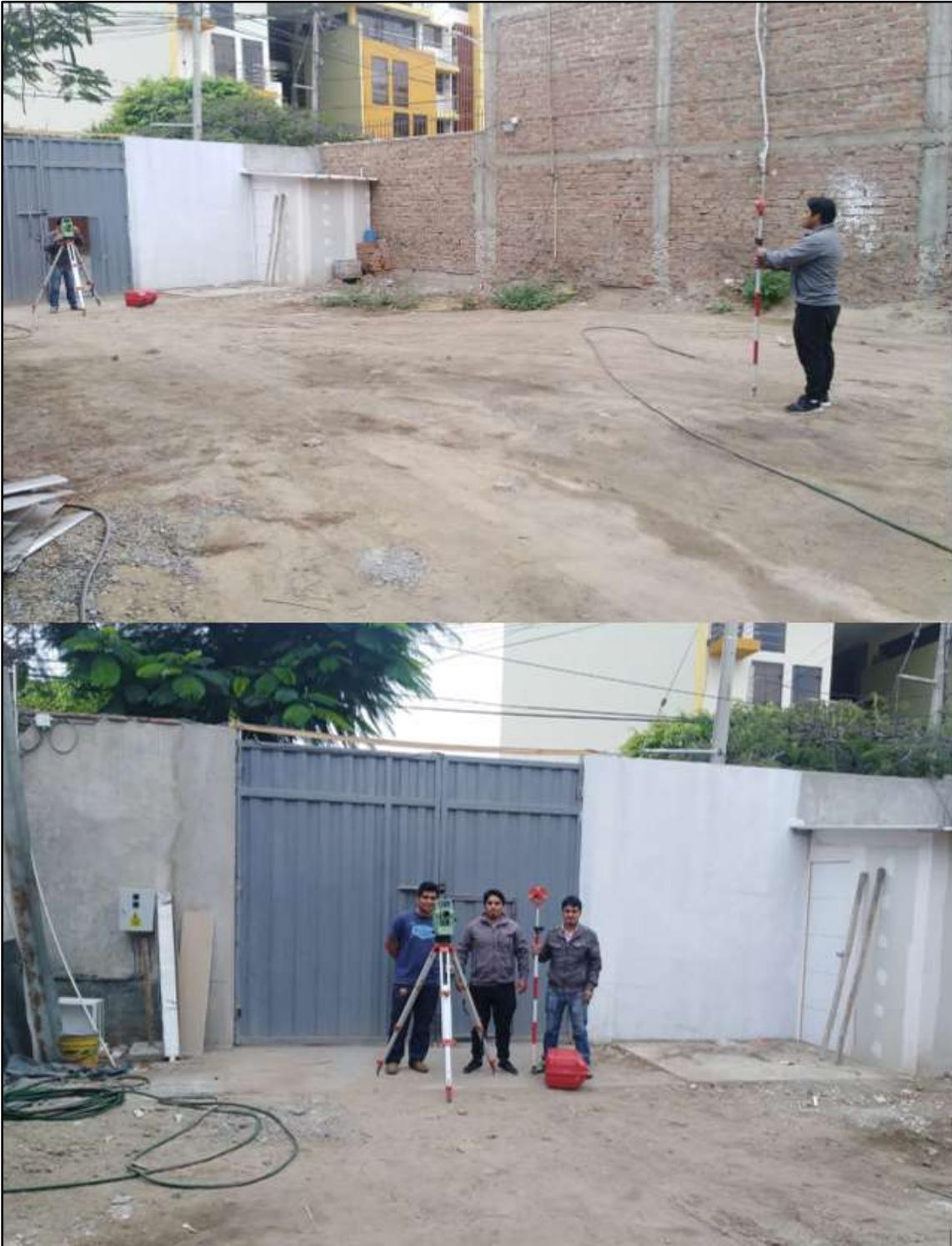
Figura 72. Levantamiento topográfico del terreno con estación total
