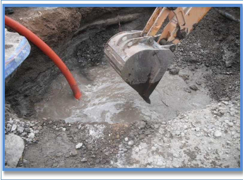
Figura 12: Se observa el nivel alto de Napa Freática
