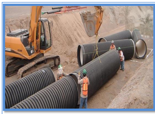
Figura 71: Tubería de Polietileno de Alta Densidad (PEAD) corrugado para drenaje sanitario y pluvial en sistemas a gravedad
