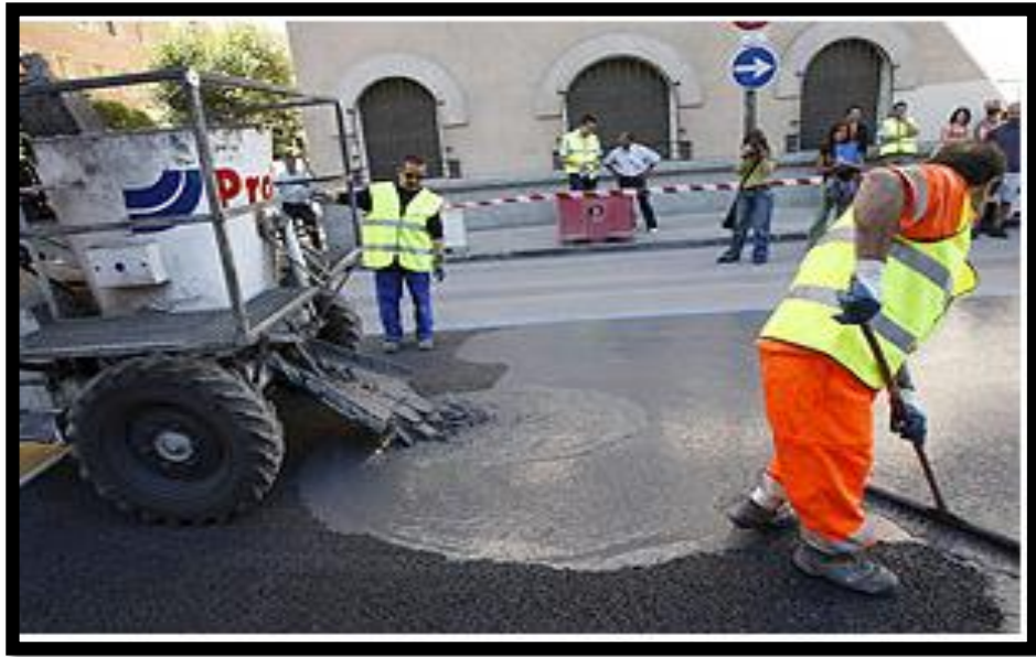
Figura 5: Pavimentación con Noxer
