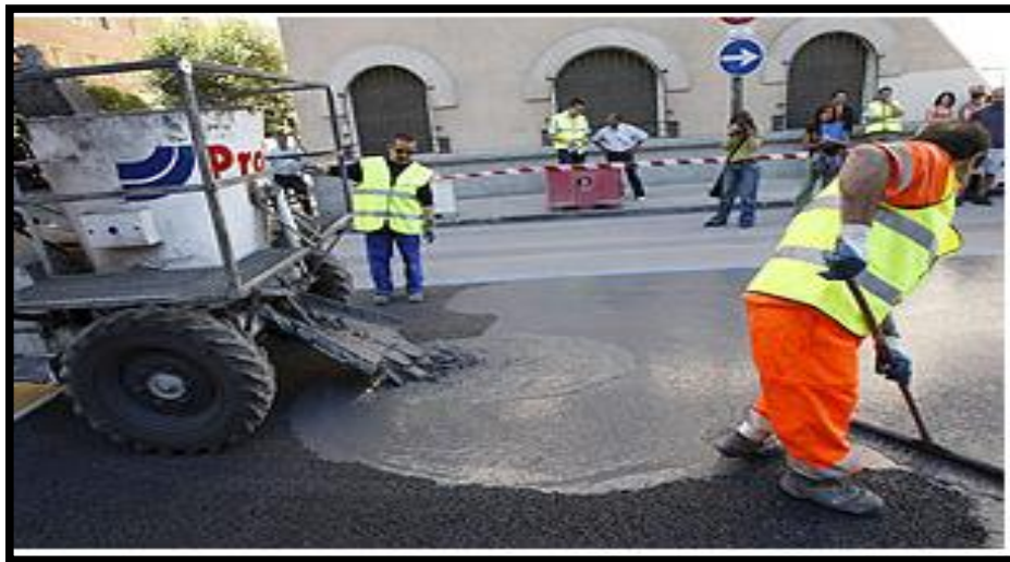
Figura 24: Pavimentación con Noxer
