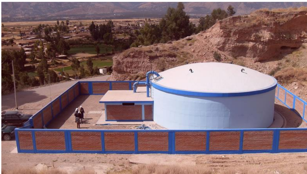
Figura 1 Planta de tratamiento de aguas residuales - Distrito de Chupaca
