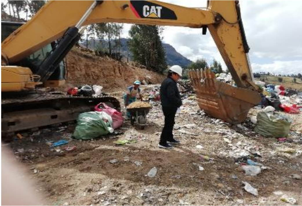
Verificacion de maquinaria
