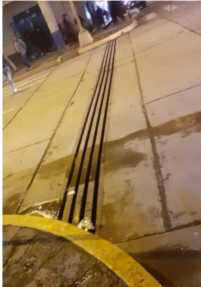
FIGURA N°3: Los residuos sólidos que se encuentran por ingresar dentro de la alcantarilla
