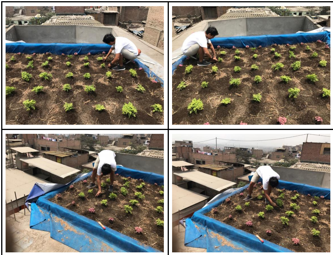
Figura N°10: Instalación de Capa de Vegetación
