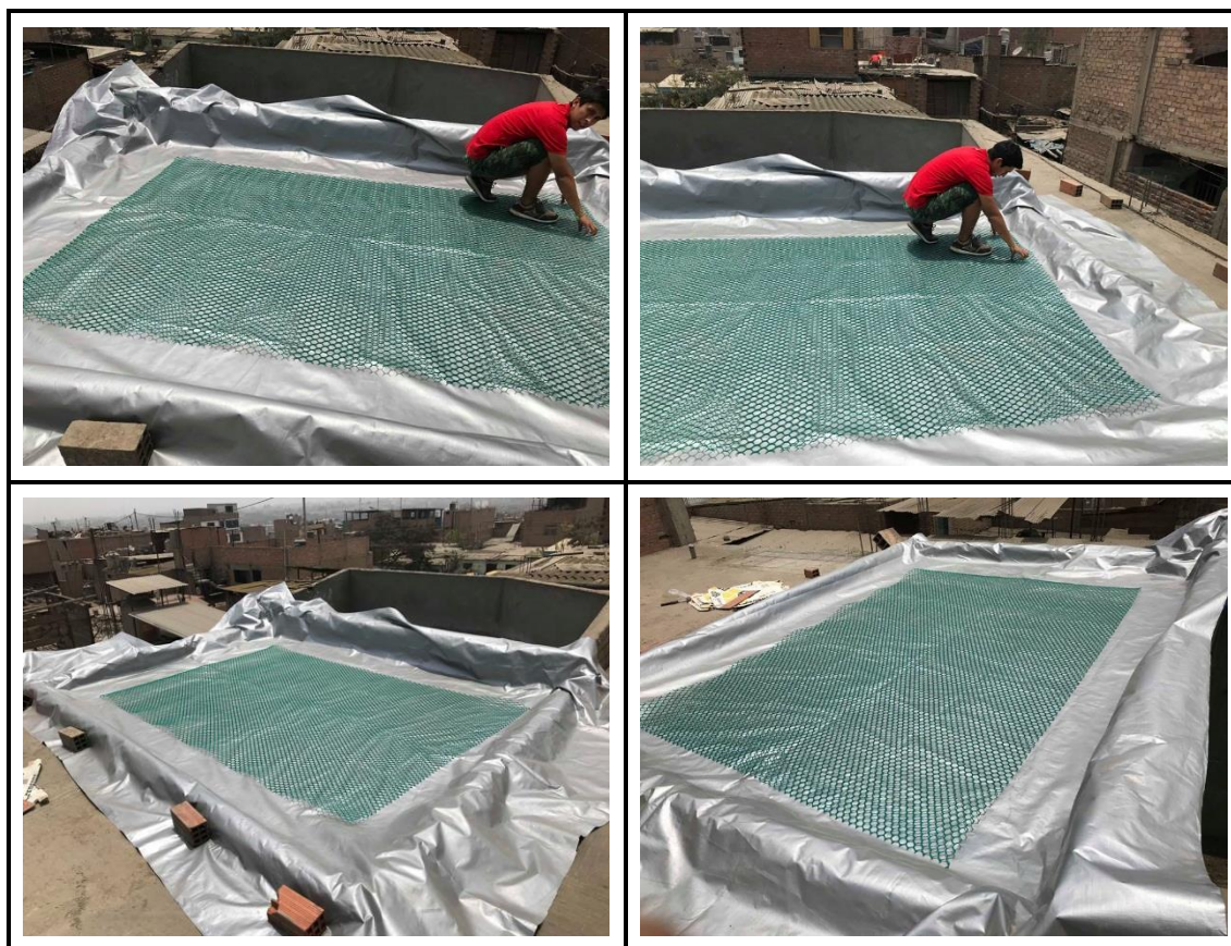
Figura N°07: Instalación de la Capa Drenante
