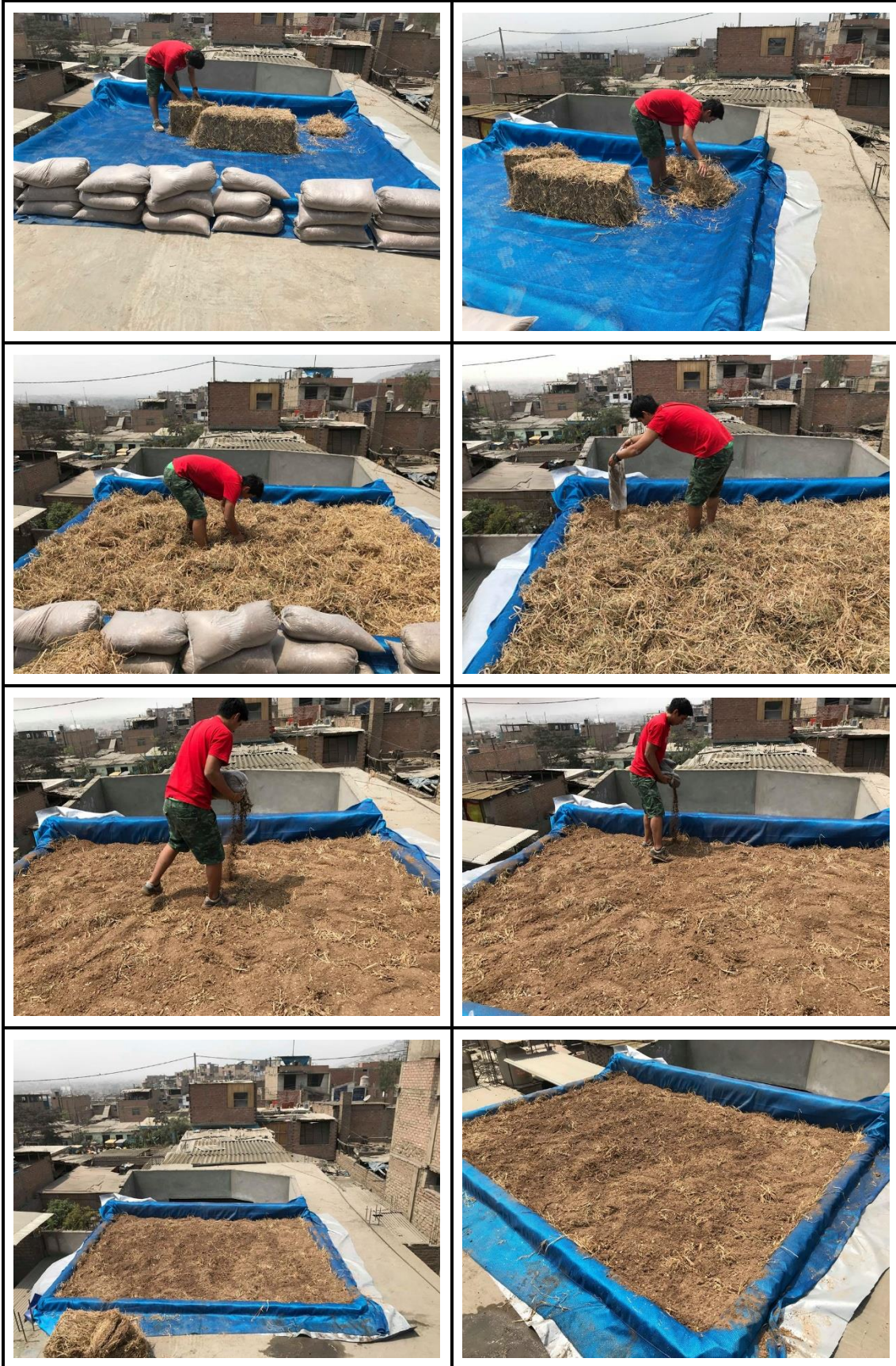
Figura N°09: Colocación del Sustrato Fuente: Elaboración propia
