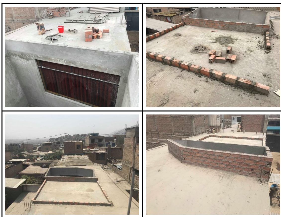
Figura N°05: Construcción de la delimitación de la habitación
