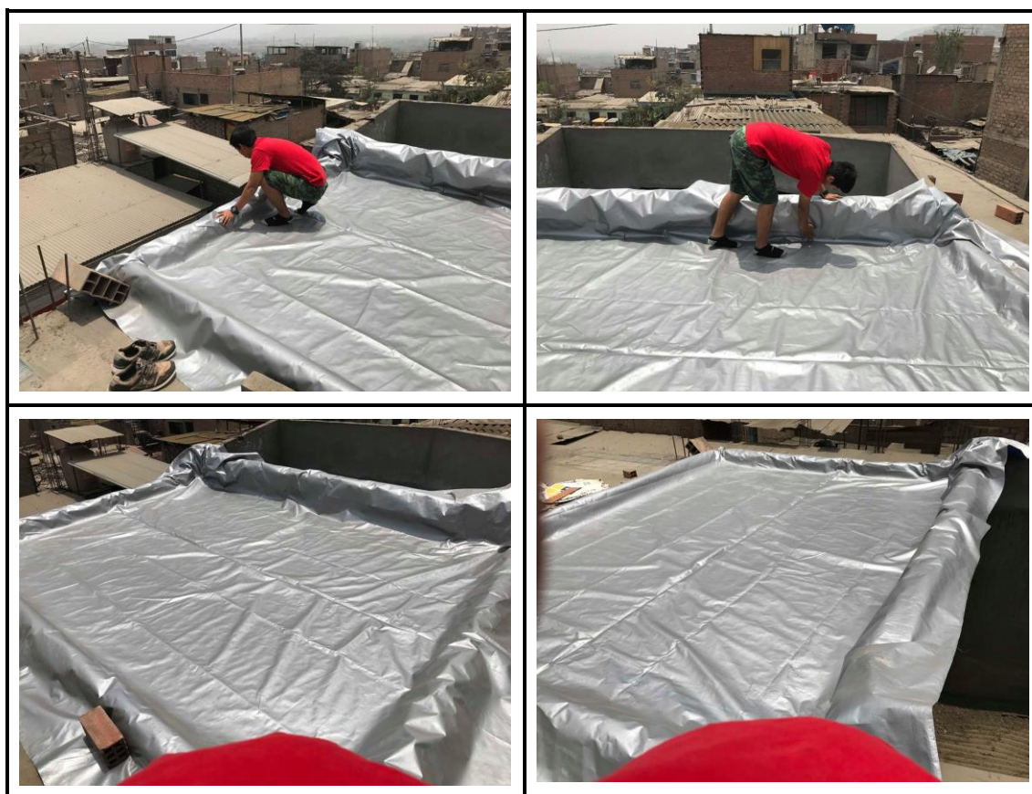
Figura N°06: Instalación de Membrana Impermeabilizante
