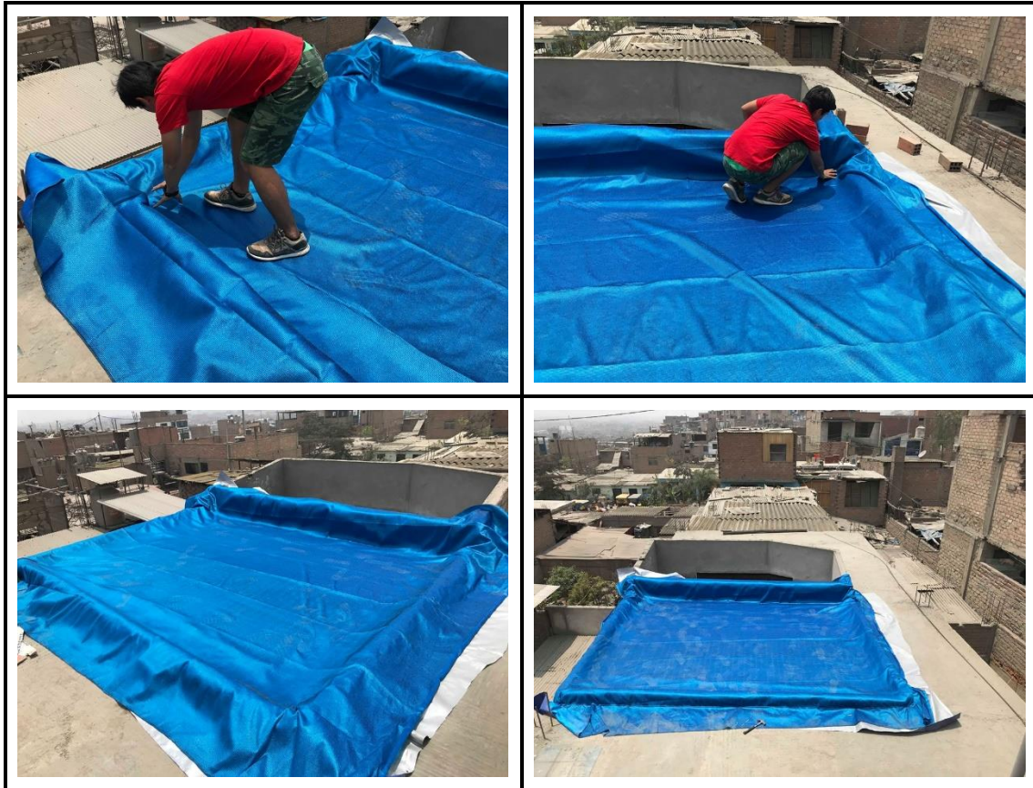
Figura N°08: Instalación de la Capa Filtrante
