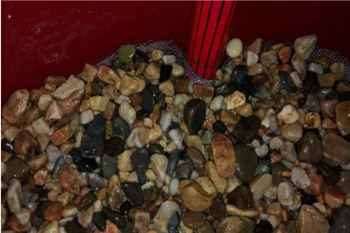
FIGURA N° 23 Llenado de los 5 cm de la tercera capa con gravilla de 1cm de diámetro
