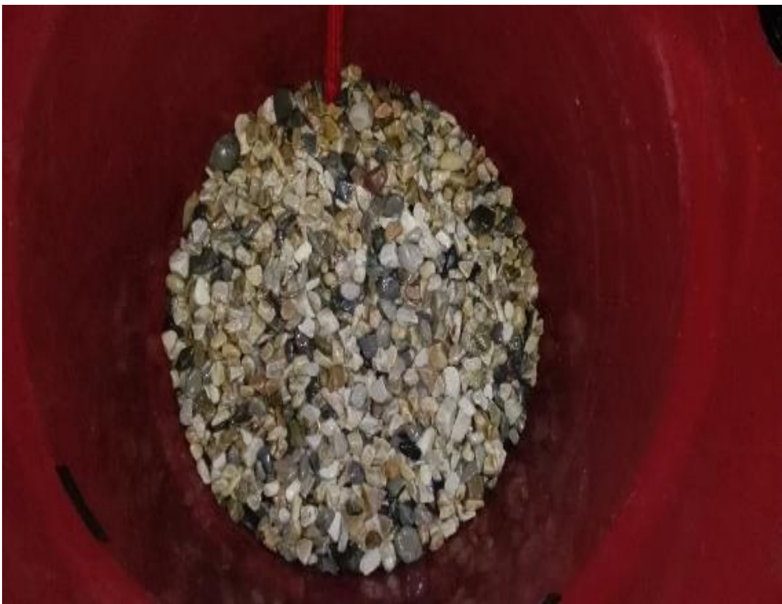
FIGURA N° 20 Llenado de los 5 cm de la segunda capa filtrante
