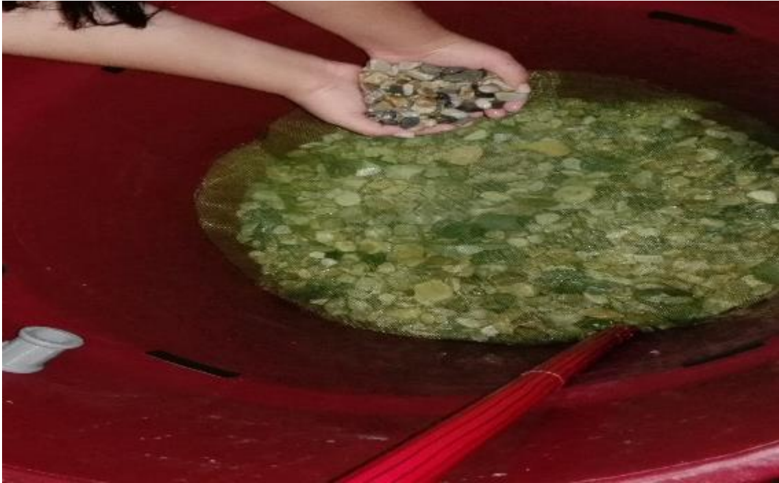
FIGURA N° 19 Llenado de la segunda capa de 5 cm de piedra pequeña con un diámetro de 2.5 a 1.8 cm
