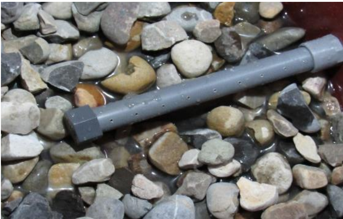
FIGURA N° 16 Llenado de los 10 cm de la primera capa filtrante con la piedras de 4 a 5 cm de diámetro
