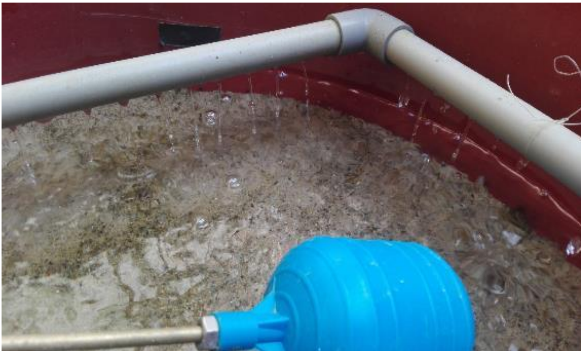
FIGURA N° 30 Paso del agua para el llenado de los 7 cm por las perforaciones que se realizó al difusor de agua para evitar el movimiento de la arena y causar obstrucciones en el filtro.
