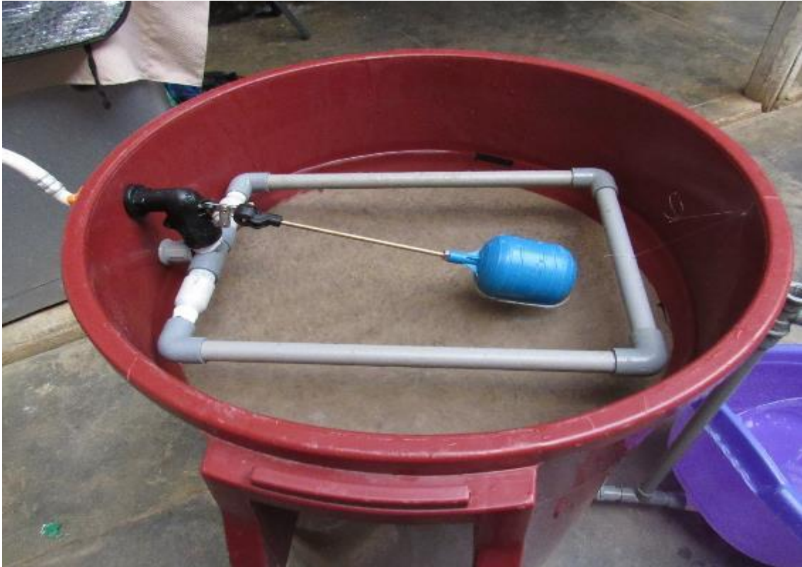
FIGURA N° 29 Llenado de agua hasta los 7 cm después de la arena fina con ayuda de la bolla la cual controla hasta el nivel que debe llegar el agua.
