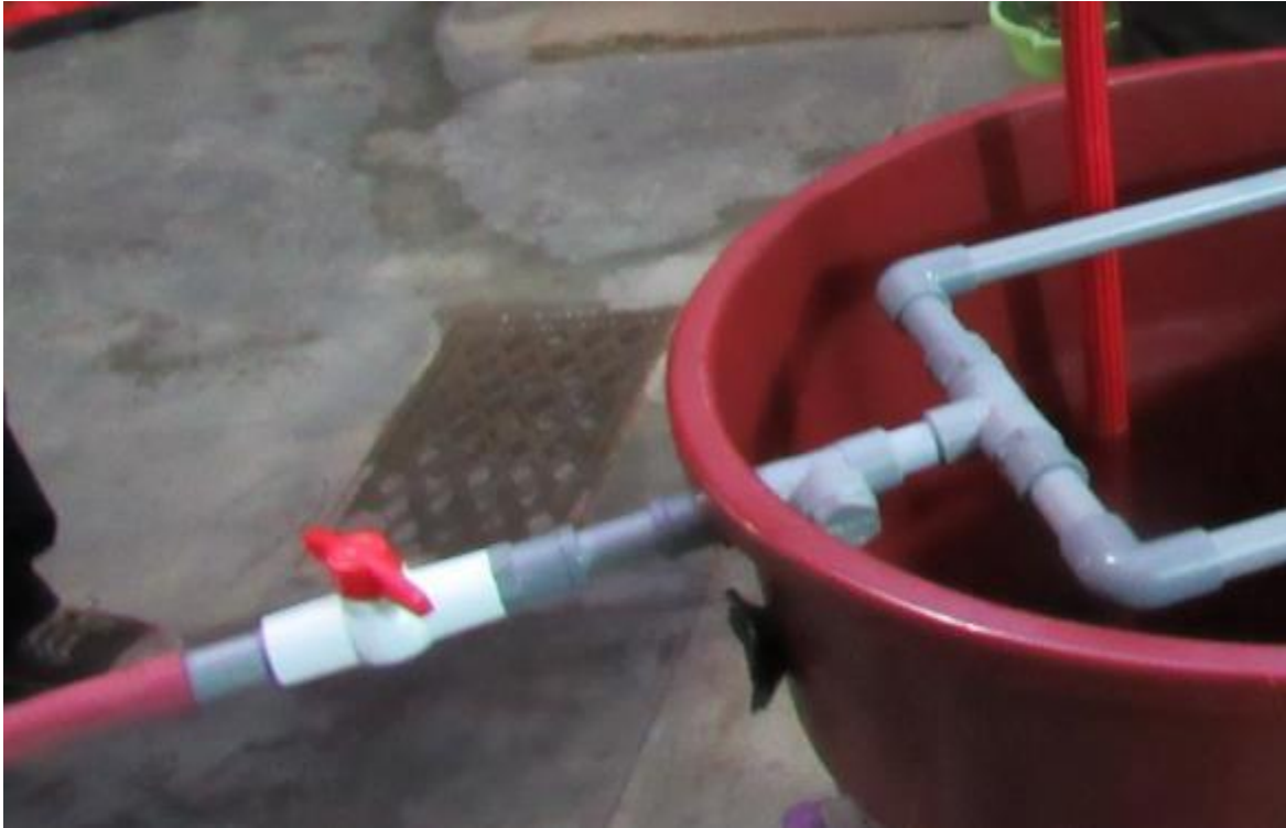
FIGURA N° 13 Armado y pegado de la entrada de agua al filtro
