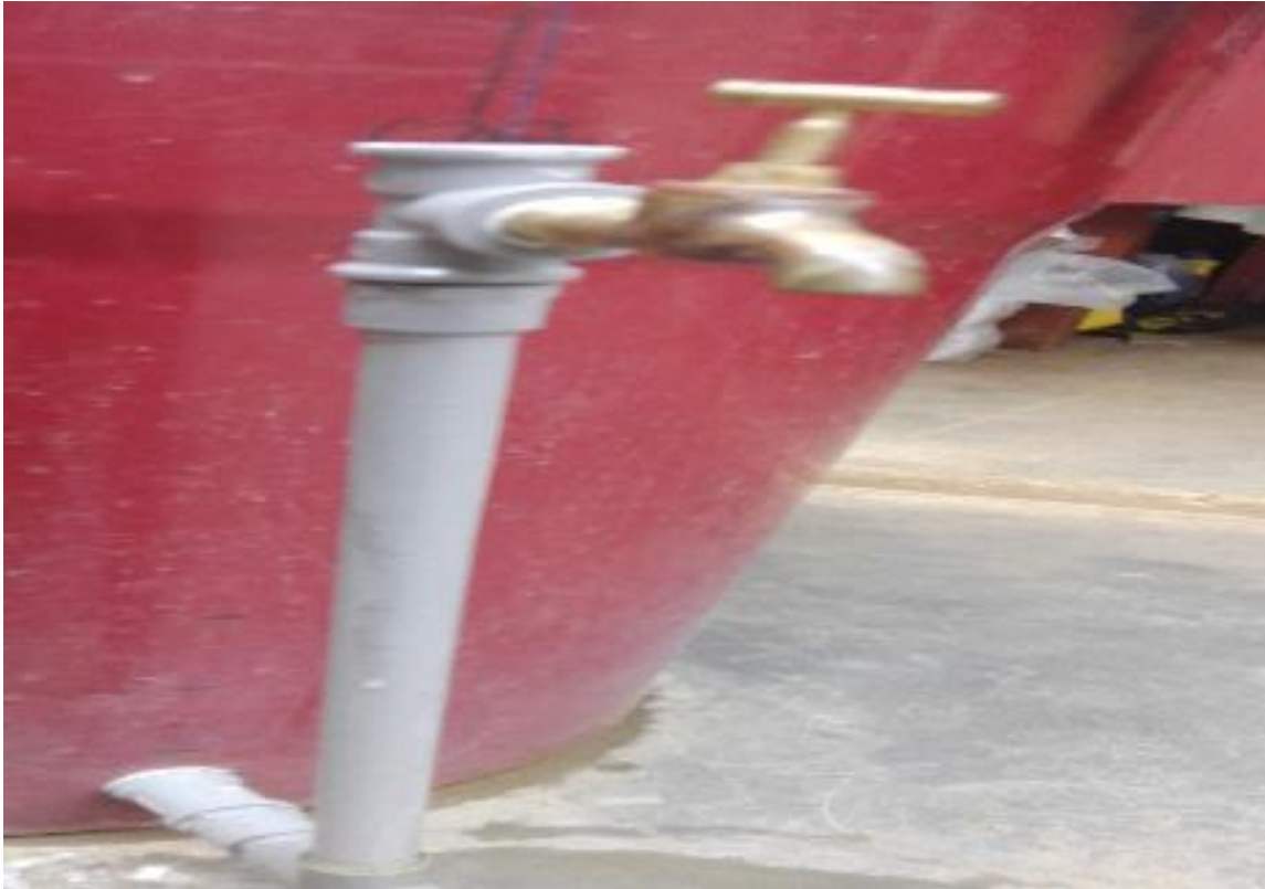
FIGURA N° 15 Armado y pagado de la salida del agua (abastecimiento del agua filtrada)
