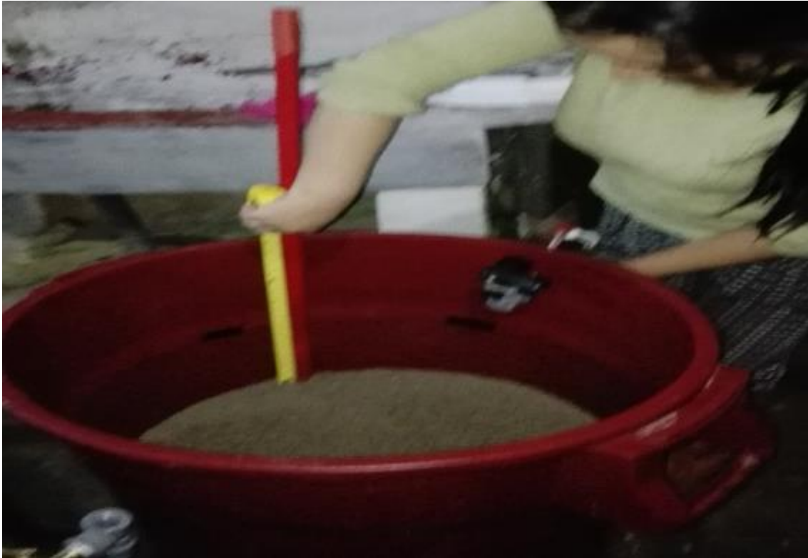
FIGURA N° 25 Toma de medida de 25 cm de altura para el llenado de la última capa filtrante conformada por arena fina
