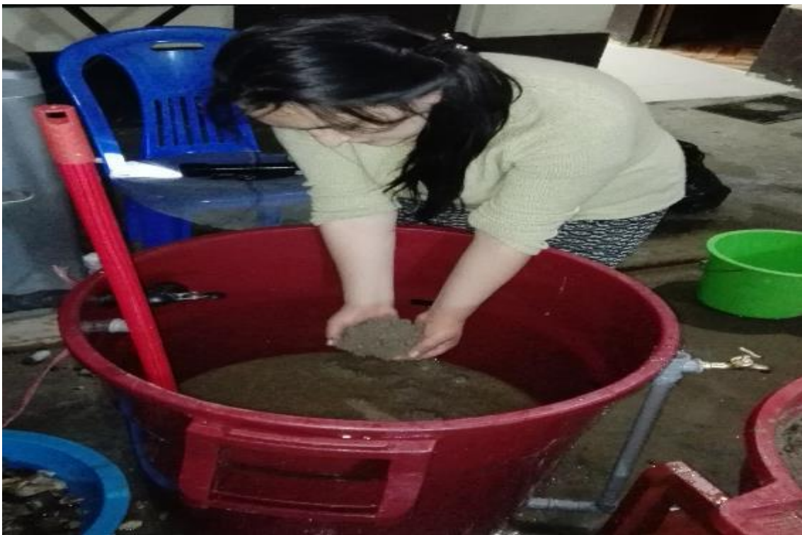
FIGURA N° 24 Incorporación de la cuarta capa filtrante con una altura de 10 cm conformada por arena gruesa lavada
