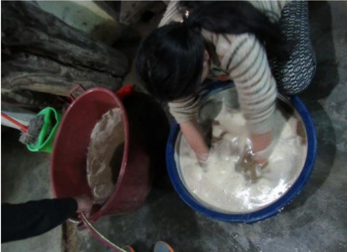
FIGURA N° 07 Lavado de la arena gruesa y fina
