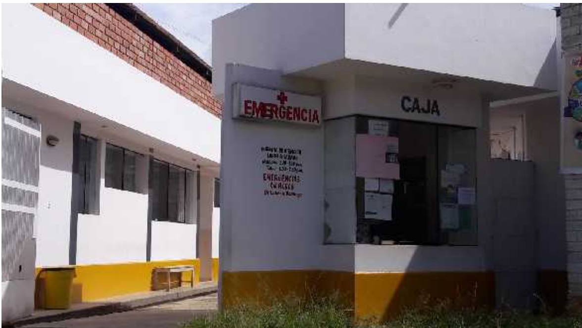
Fotografía 10: Vista de la Oficina de Caja del Centro de Salud.
