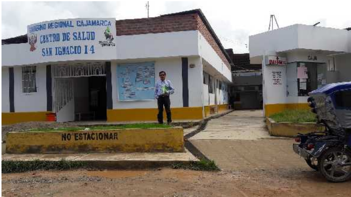
Fotografía 01: Centro de Salud San Ignacio Nivel I – 4. Vista frontal.
